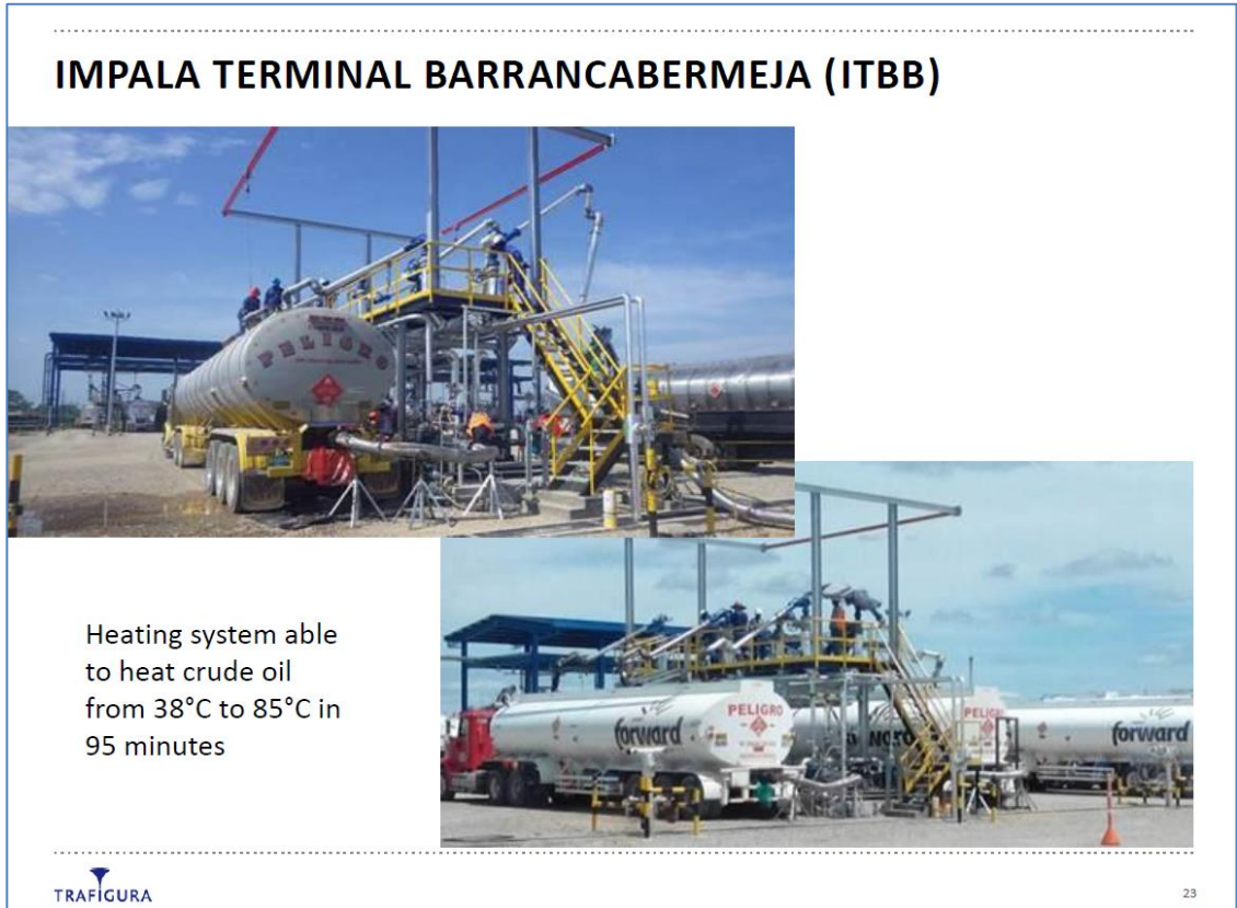
Figura 11. Infraestructura para Cargue y Descargue en Barrancabermeja
