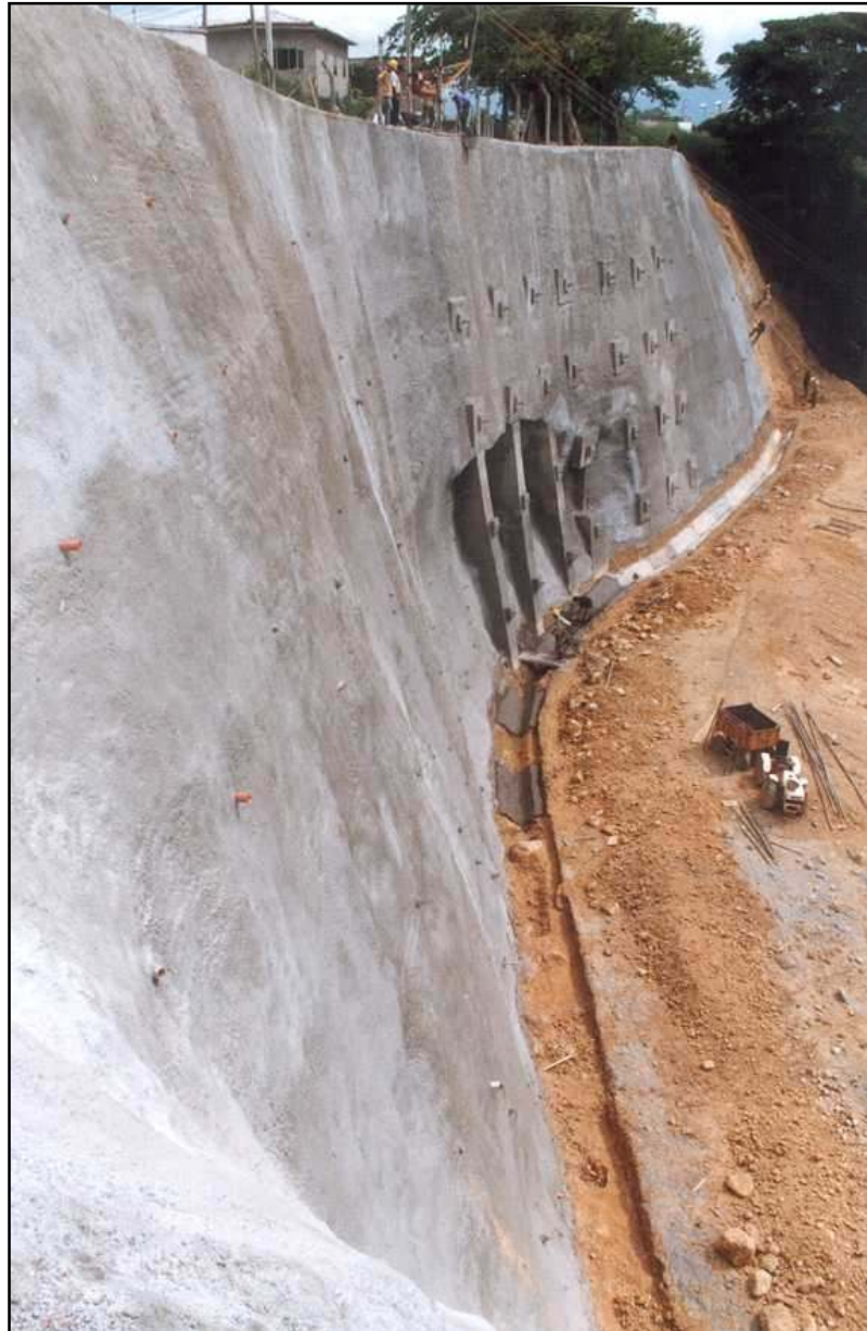
Ilustración 14. Etapa Final de Construcción de la Pantalla Anclada
