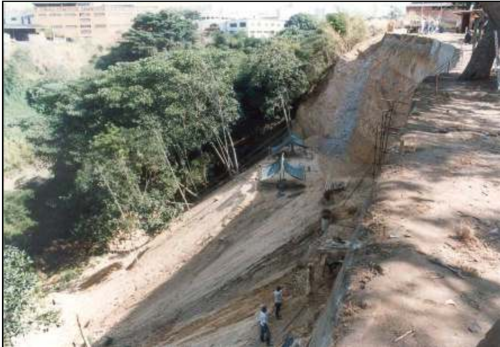
Ilustración 13. Construcción Pantalla Anclada - Año 1995
