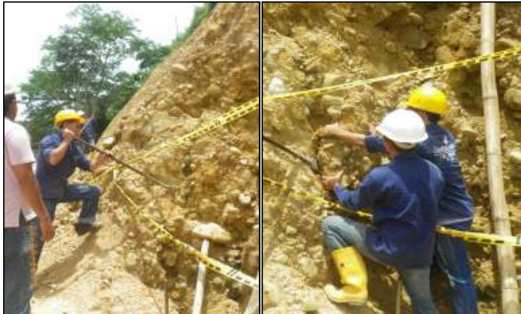
Ilustración 18. Ejecución Apique 3. Pie del talud
