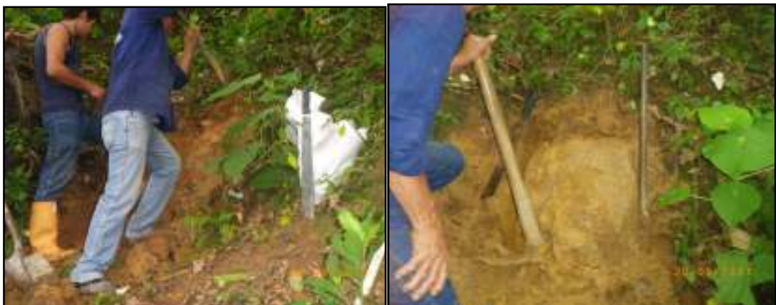
Ilustración 16. Ejecución Apique 1. Parte media del talud
