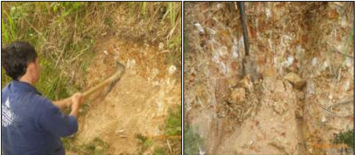
Ilustración 19. Ejecución Apique 4. Corona del talud
