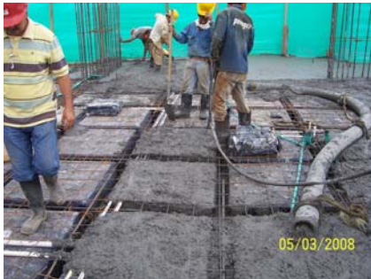
Figura 41. Fundida placa con bomba.
