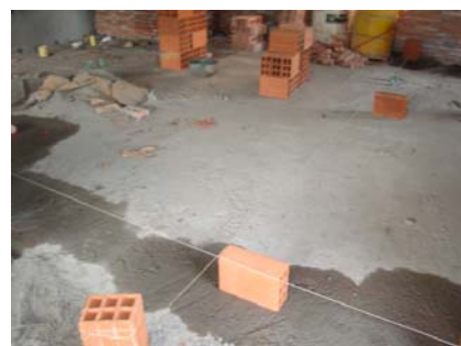
Figura 34. Trazado de hilos.
