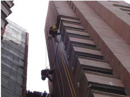
Figura 29. Lavado Ladrillo Gran Formato PV.
