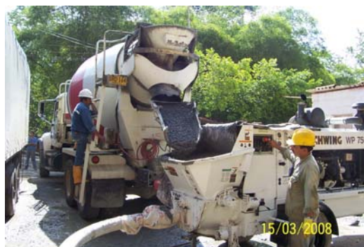
Figura 43. Vaciado concreto sobre bomba.
