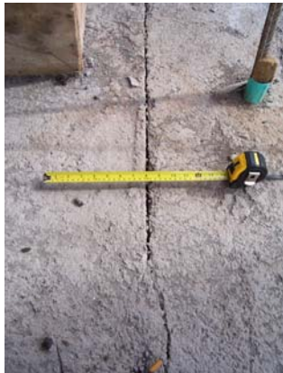
Figura 13. Flexómetro midiendo dilatación.
