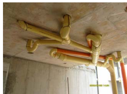
Figura 18. Araña sanitaria bajo placa.
