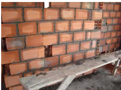
Figura 33. Revisión de brechas y plomo.
