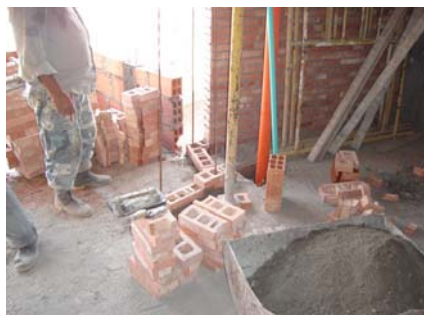
Figura 35. Ladrillo Gran Formato para ensayo.
