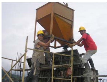
Figura 39. Góndola Para vaciar concreto sobre columnas. Figura 40. Columna recién fundida.
