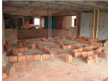
Figura 28. Replanteo Apto en ladrillo H-10.
