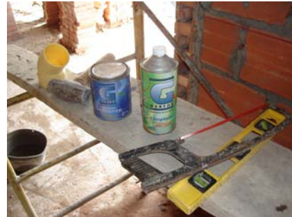
Figura 16. Equipos y materiales de soldadura.
