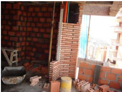
Figura 31. Muro mampostería exterior.
