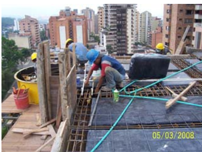
Figura 22. Replanteo red hidráulica.
