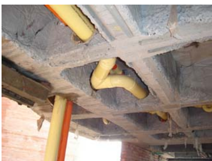
Figura 17. Pendiente y recorrido horizontal.
