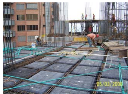
Figura 23. Recorrido tubería hidráulica.
