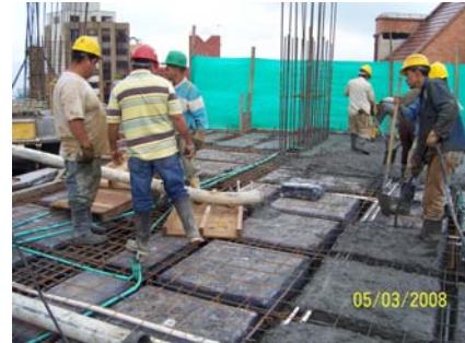
Figura 42. Fundida placa con bomba.
