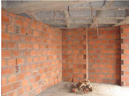
Figura 27. Muro de mampostería no estructural.
