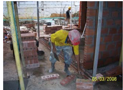
Figura 32. Muro mampostería interior.
