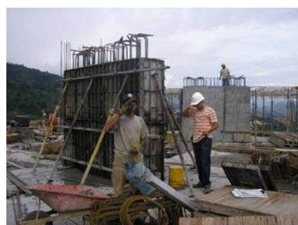
Figura 39. Góndola Para vaciar concreto sobre columnas. Figura 40. Columna recién fundida.
