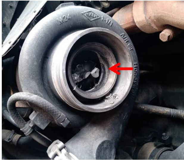
Figura 50. Destrucción de alabes turbina contra alojamiento interno TurboCompressor, por desalineación del eje del Turbo.
