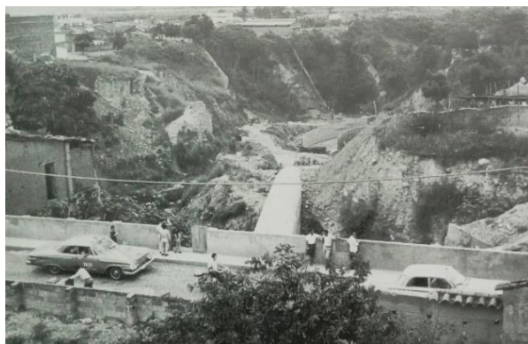
Canalización Quebrada La Rosita
