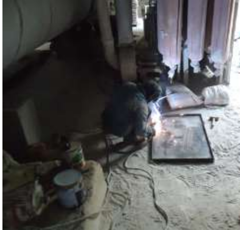
Figura 13. Soldadura de elementos
