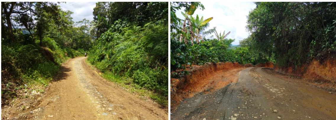
Figura 17 Comparación de un antes y después de realizar la explanación
