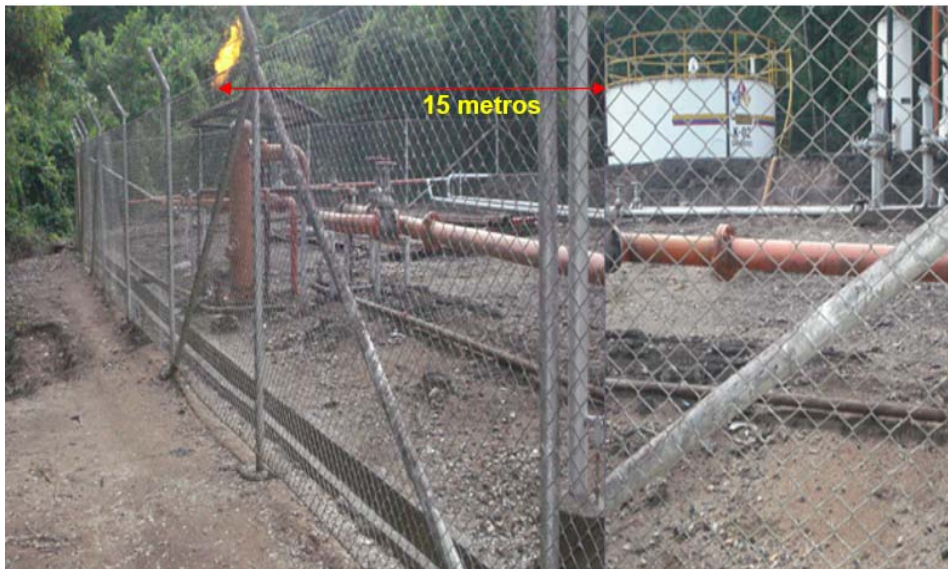
Figura 6. Distancia entre la llama de la Tea y el Tanque
