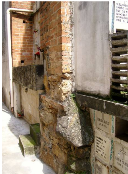
Figura 5.13 Vista de una columna en la parte trasera de la Catedral. Fuente: Las autoras
