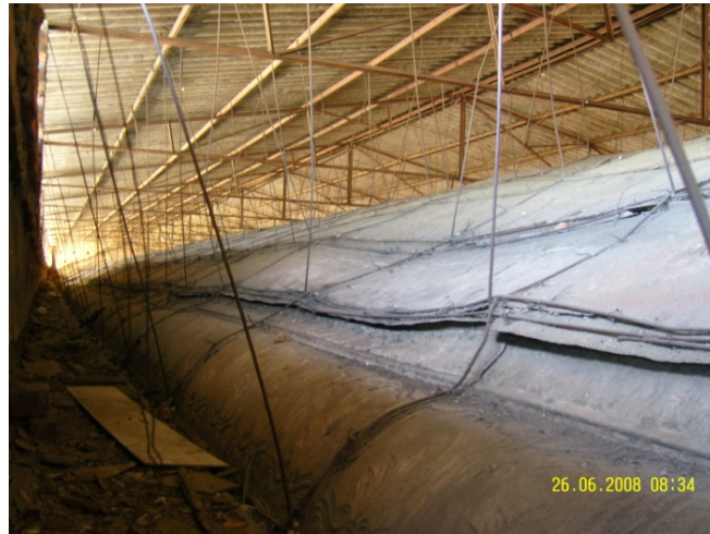
Figura 5.22 Detalle de la cubierta de la nave central
