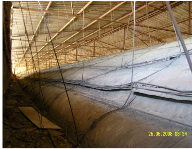
(a) Vista piso Catedral (b) Bóveda de Lámina acanalada de la nave central
