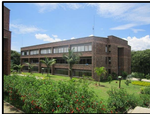
Figura 3. Panorámica Edificio de aulas
