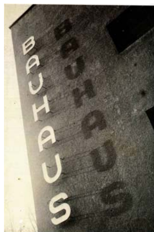
Escuela de Diseño Bauhaus – Detalle fachada edificio
