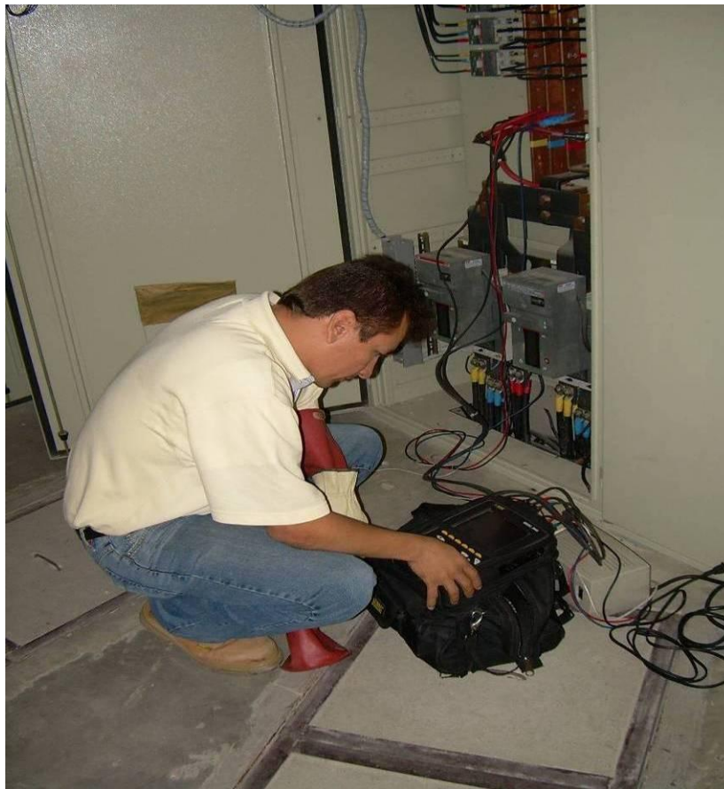
Figura 2.1 Mantenimiento correctivo en el edificio CENTIC
