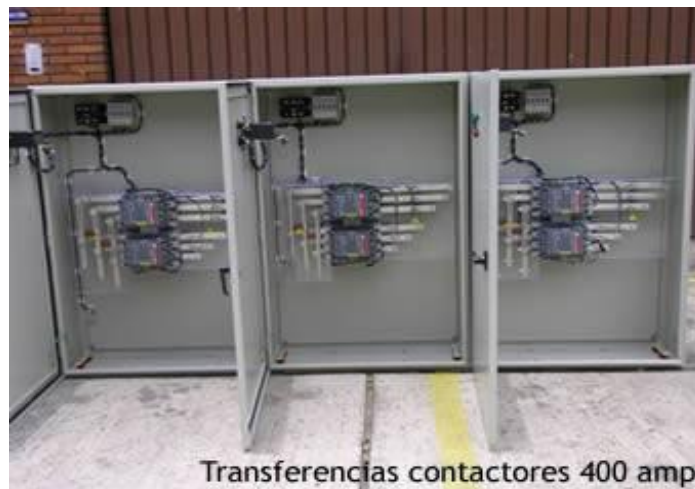
Figura 1.29 Transferencias con contactores
