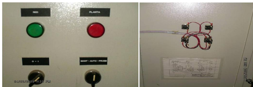
Figura 2.16a STE armado del edificio de administración
