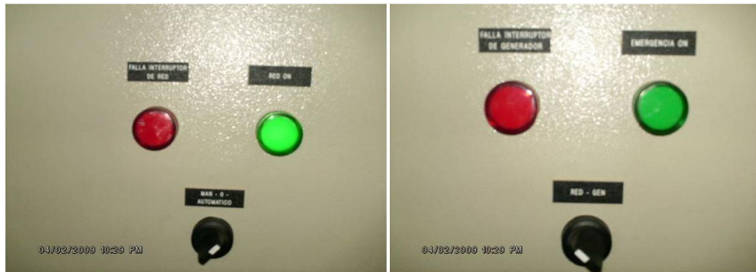
Figura 2.7 Interruptores del control de STE
