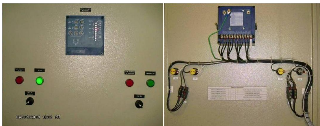
Figura 2.6 Módulo de transferencia electrónica
