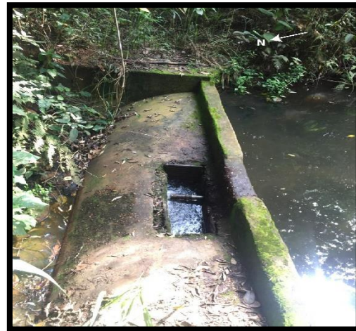
Figuras 39. y 40. Represa mal elaborada que abastece el acueducto de la Vereda La Aguada.
