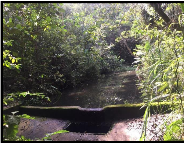
Figuras 39. y 40. Represa mal elaborada que abastece el acueducto de la Vereda La Aguada.
