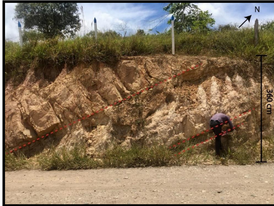
Figura 10. Delta número uno (1) en donde se tomaron los datos estructurales. Margen izquierdo vía Vereda Llanadas -Vereda La Aguada.
