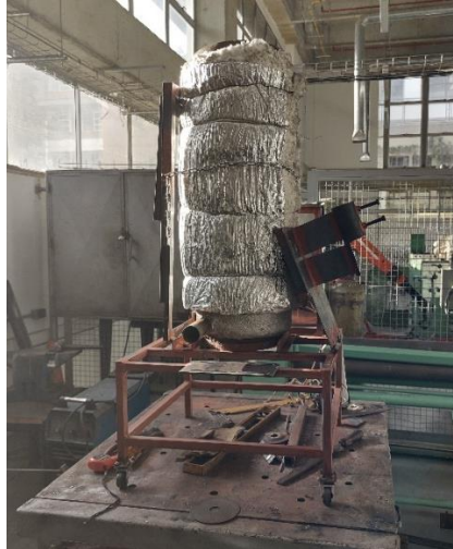
Figura 57. Instalación del soporte para el quemador a gas.
