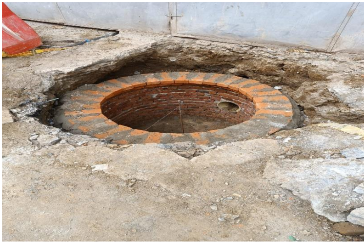
figura 21 Pozo de inspección
