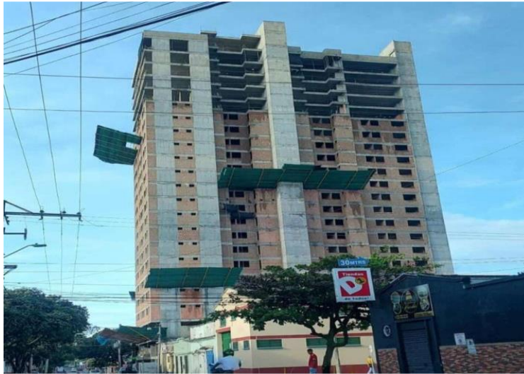
figura 14 Avance de mampostería desde calle 16
