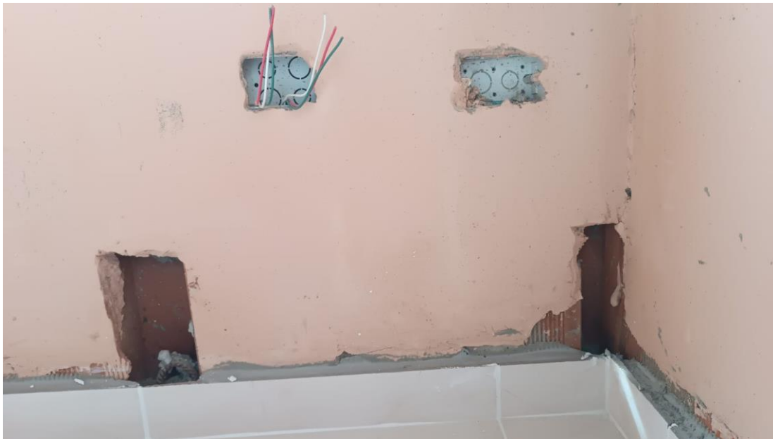
figura 23 Acometida de cable y resane pendiente
