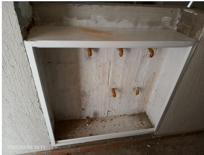
figura 22 Puntos para el medidor de gas
