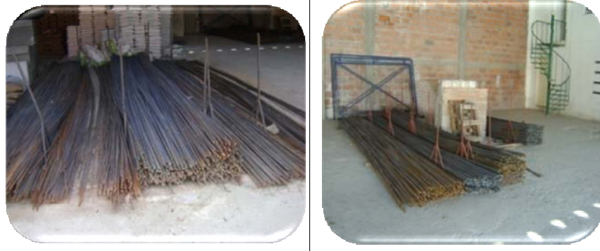
Imagen 39. Almacenamiento de hierros
