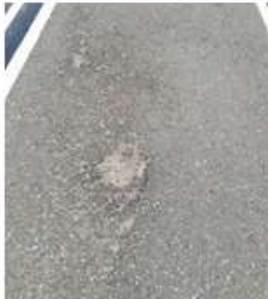
Descascaramiento (DC)
