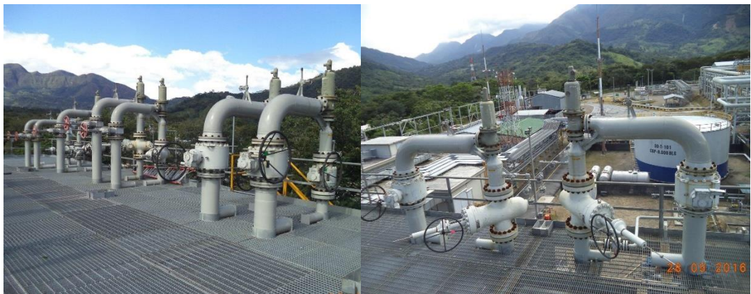
Figura 7. Válvulas de alivio de seguridad balanceadas por fuelle
