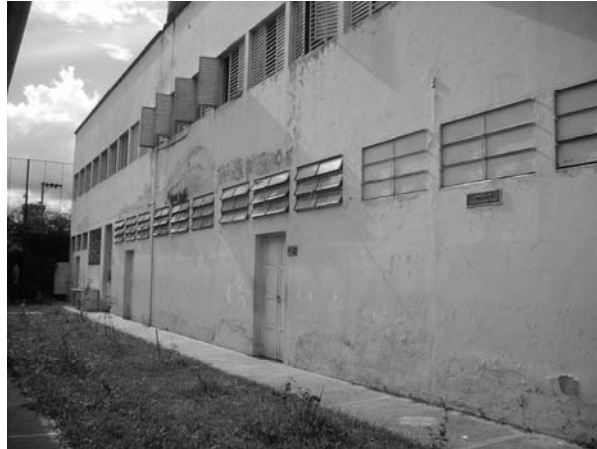
FOTOGRAFÍA 9: Pabellón Francisco Gómez Pinzón del Instituto Psiquiátrico San Camilo 1955
