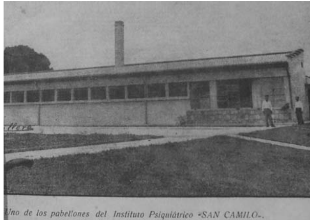
FOTOGRAFÍA 6: Pabellón del Instituto Psiquiátrico San Camilo construido en 1953
