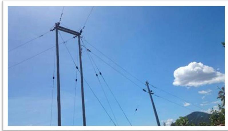
**Figura 4.** Derivación red a 7.62kV de una red a 13.2kV. Fuente: autores.
