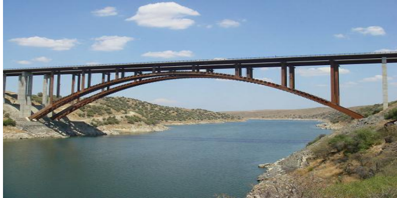
Figura 2. Puente en arco
