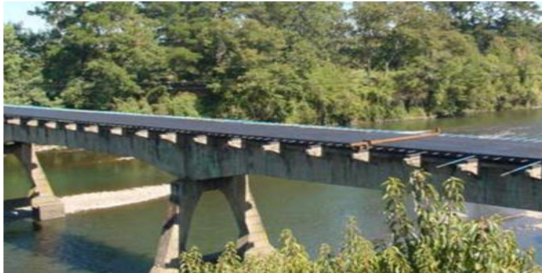
Figura 4. Puente en placa
