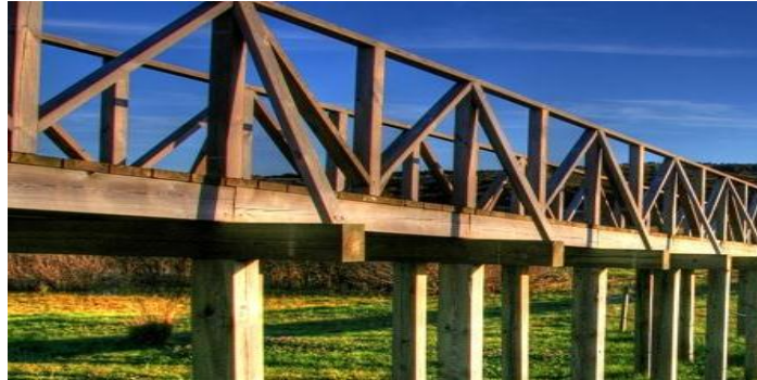
Figura1. Puente en viga
