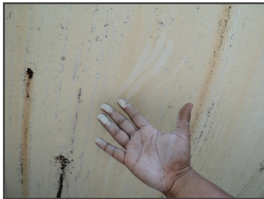
Figura. 6 Entizamiento del recubrimiento.
