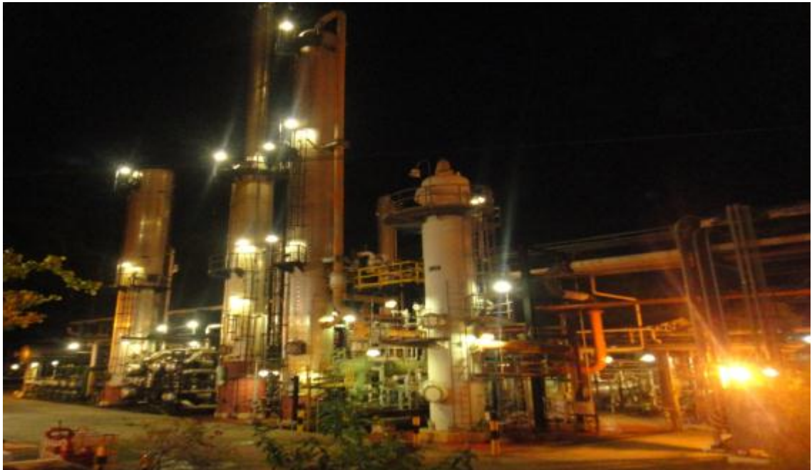
Figura 2. Registro fotográfico de la Planta de procesos de gas El Centro.
