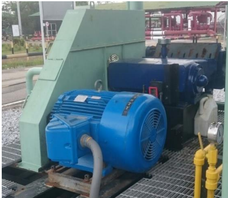
Figura 13 Bomba Quintuplex y motor eléctrico.
