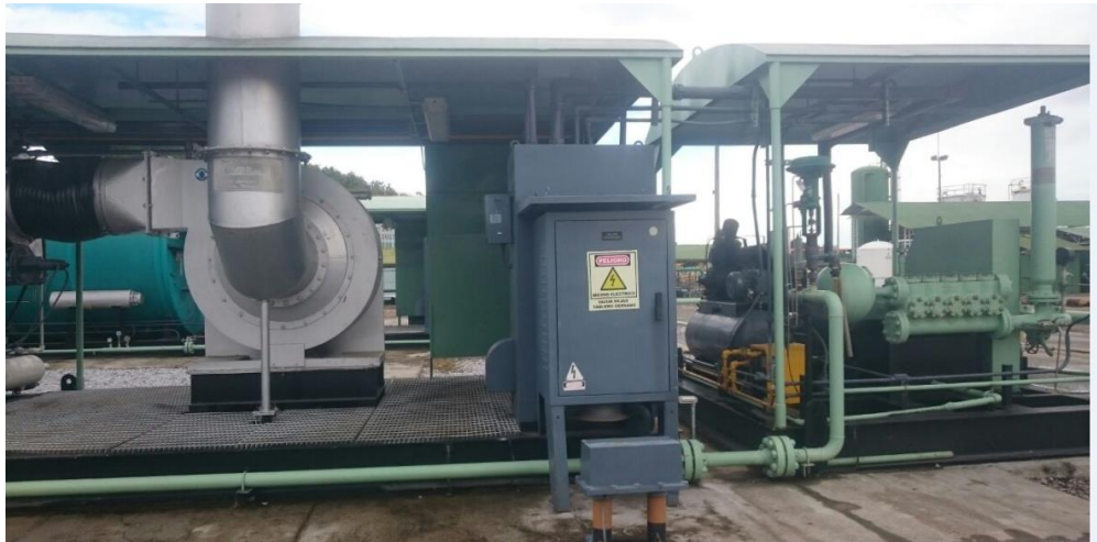
Figura 13 Bomba Quintuplex y motor eléctrico.
