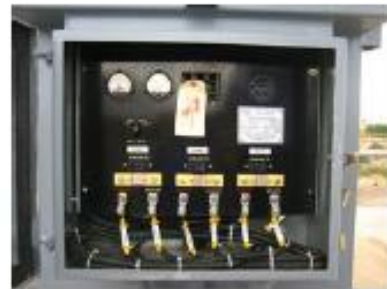
Fotografía 14. Conexión cable anódico principal en rectificador
