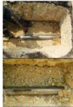
Fotografía 18. Perforación dirigida para la instalación de electrodos de referencia permanentes.
