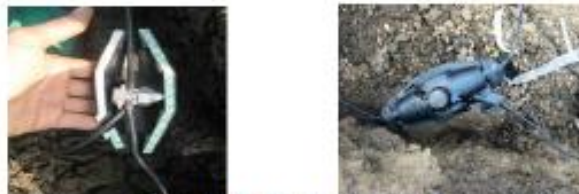
Fotografía 21. Empalme cable ánodo de sacrificio
