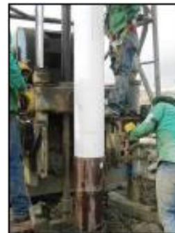
Fotografía 8. Taladro perforador para la construcción de camas anódicas
