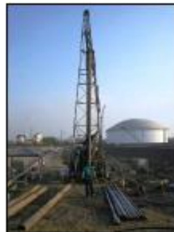
Fotografía 8. Taladro perforador para la construcción de camas anódicas
