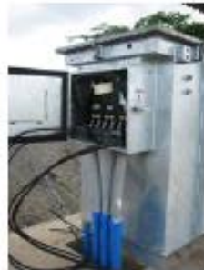
Fotografía 14. Conexión cable anódico principal en rectificador
