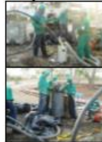
Fotografía 10. Vaciado de coque de petróleo calcinado por bombeo mecánico.
