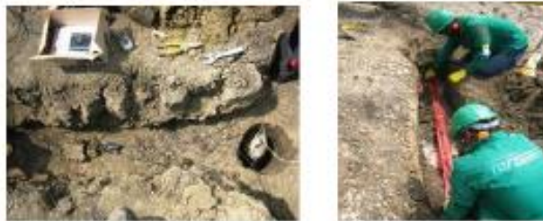
Fotografía 22. Instalación ánodo de sacrificio.
