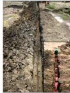
Fotografía 13. Cable anódico principal con aislamiento HMWPE para enterramiento directo
