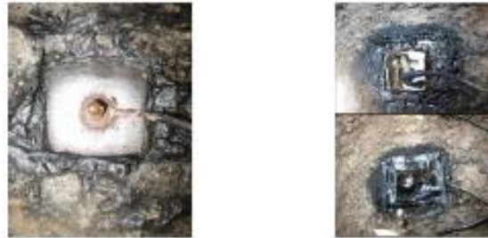
Fotografía 20. Soldadura exotérmica para conexión de ánodo de sacrificio.
