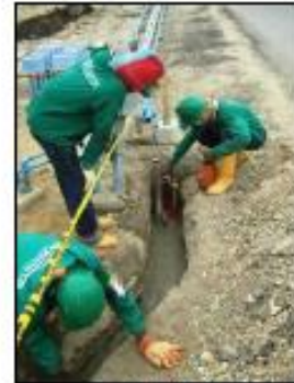
Foto 2. Protección con tubería acometida
