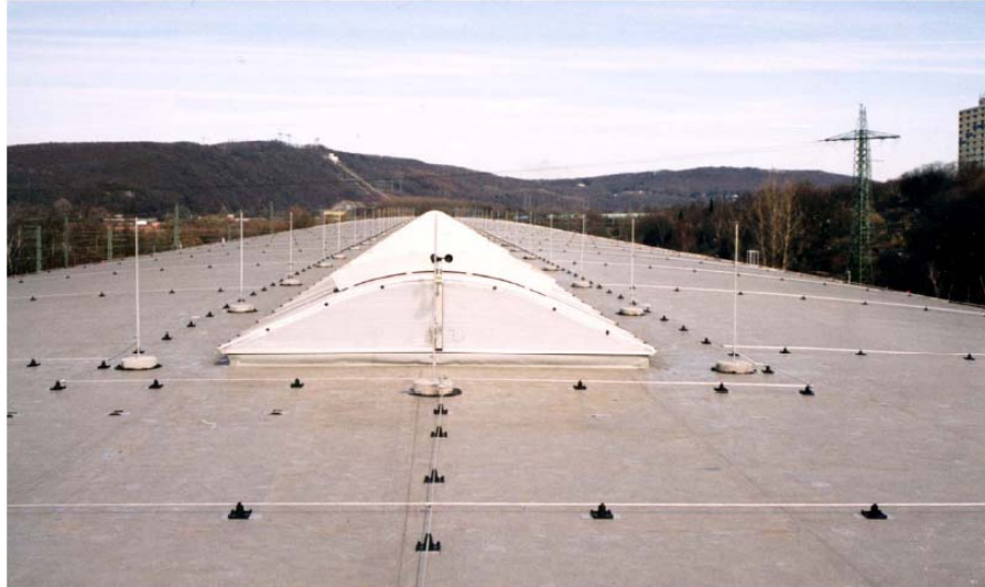
Figura 5.4 Sistema de captación tipo malla
