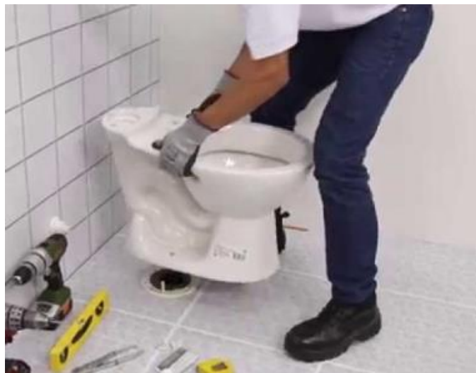
Ilustración 64. Instalación de aparatos sanitarios.
