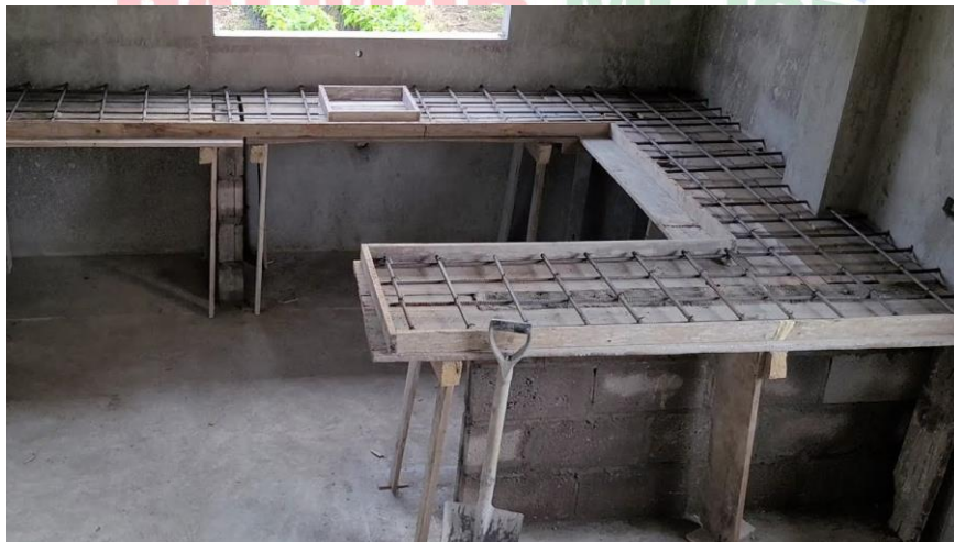
Ilustración 26. Construcción de concreto.
