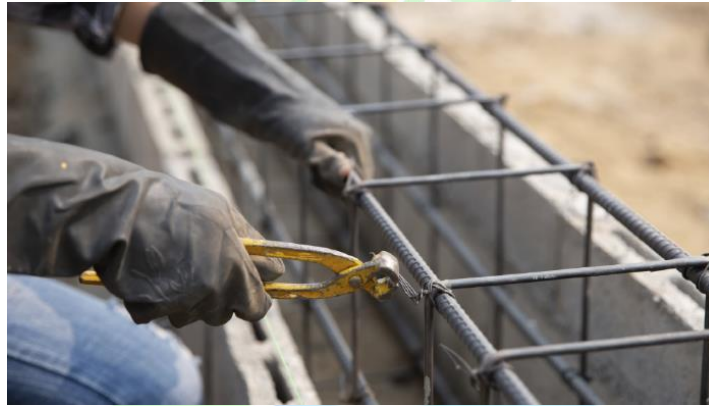
Ilustración 92. Instalación de acero de refuerzo.
