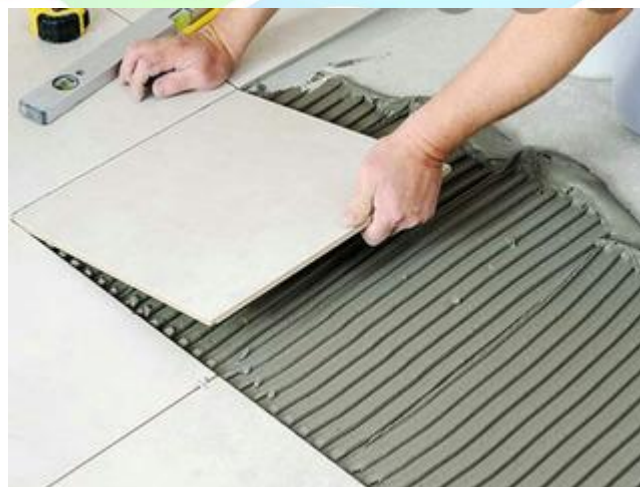
Ilustración 46. Instalación de pisos de baño.
