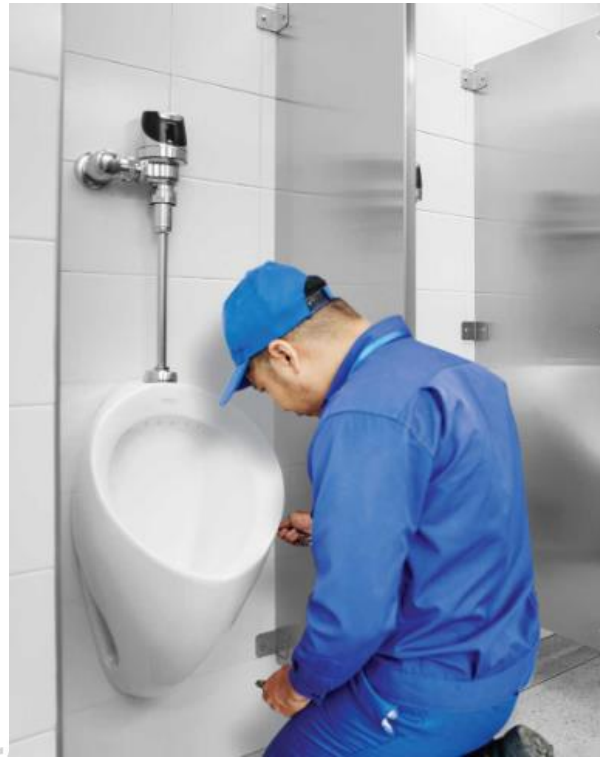
Ilustración 66. instalación de orinal.
