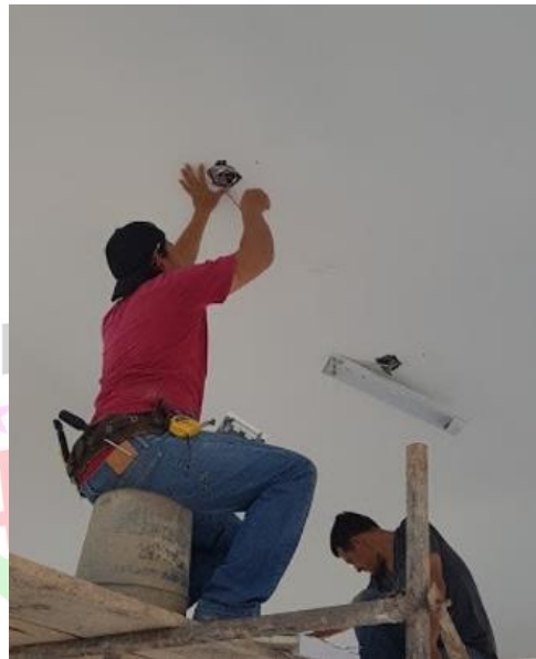
Ilustración 63. Instalación luminarias.
