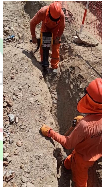
Ilustración 7. Excavación en roca.
