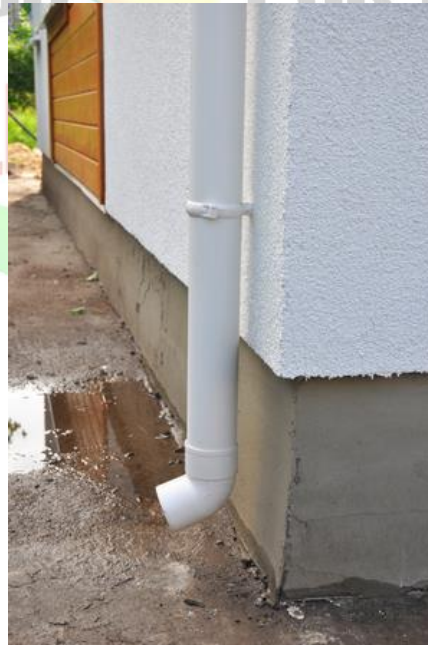
Ilustración 80. instalación de bajantes.
