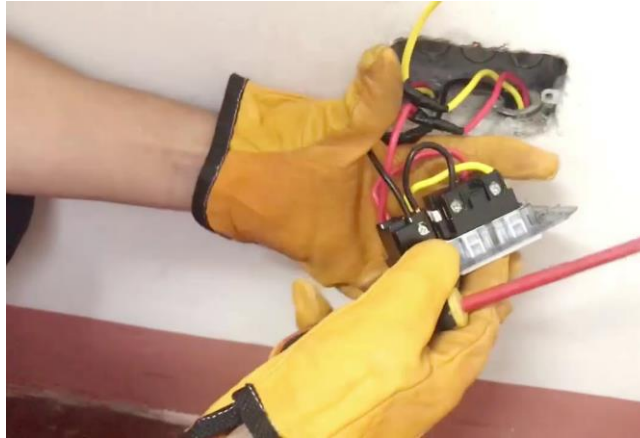
Ilustración 62. Instalación toma corriente.
