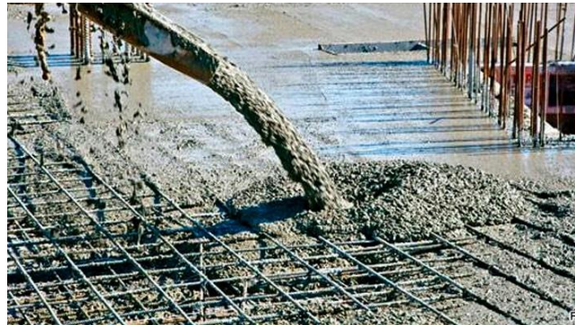
Ilustración 20. Construcción de losa en concreto.
