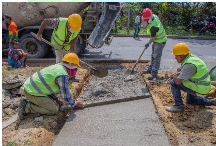
Ilustración 23. Construcción de andenes.
