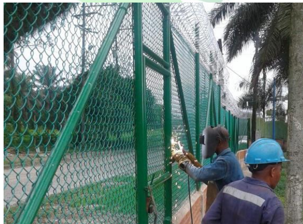
Ilustración 97. instalación de malla eslabonada.
