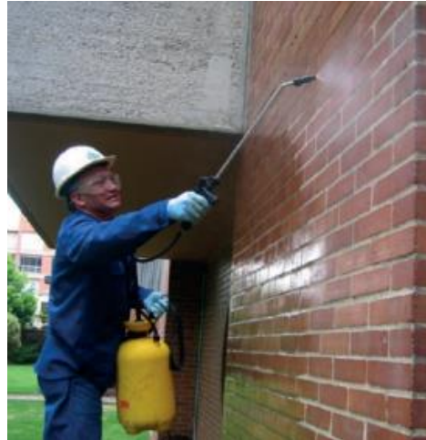
Ilustración 44. Lavado e hidrofugado.
