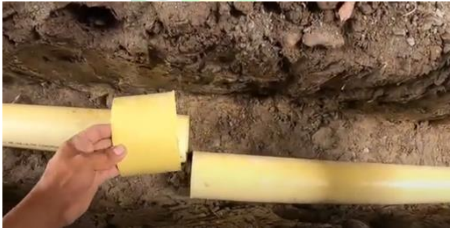
Ilustración 72. instalación tubería sanitaria.
