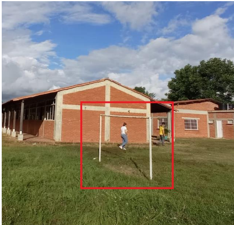
Ilustración 2. Retiro arcos metálicos cancha existente.
