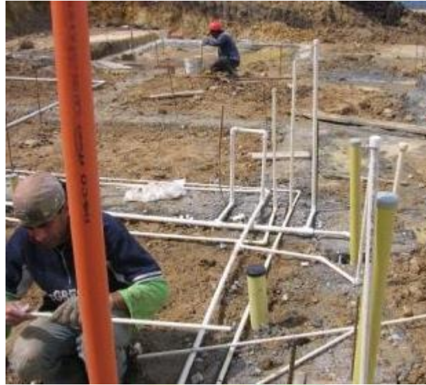
Ilustración 70. instalación punto hidráulico.
