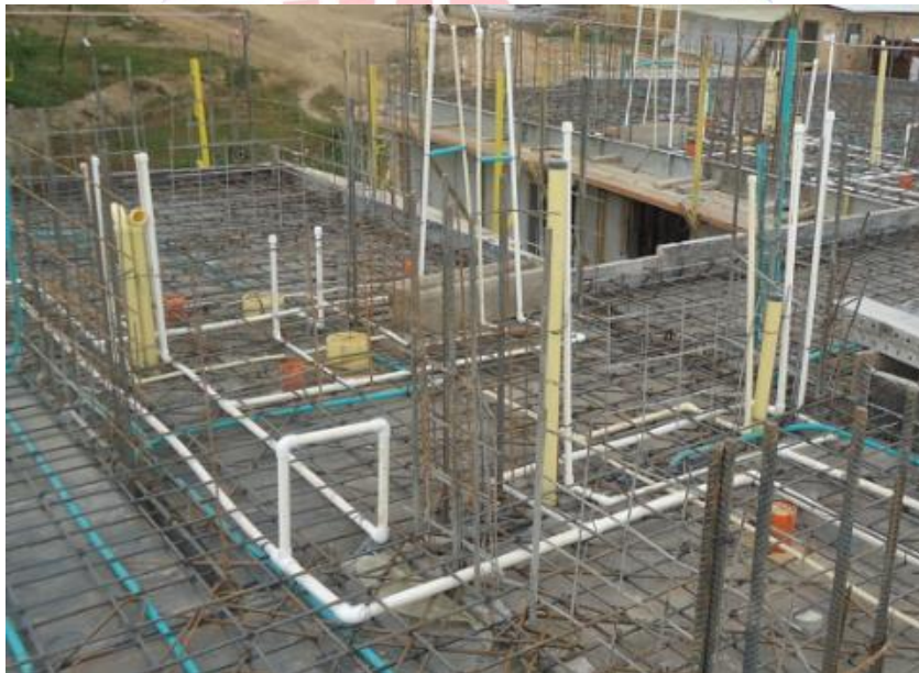
Ilustración 78. Instalaciones hidráulicas.
