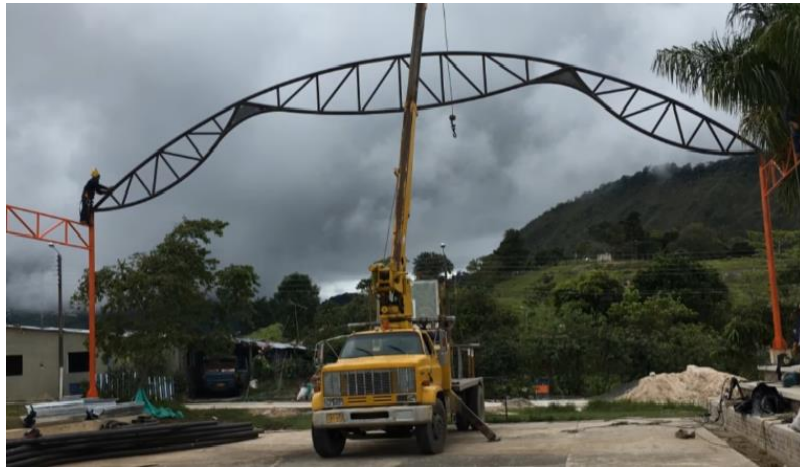
Ilustración 35. Montaje de cerchas metálicas principales.
