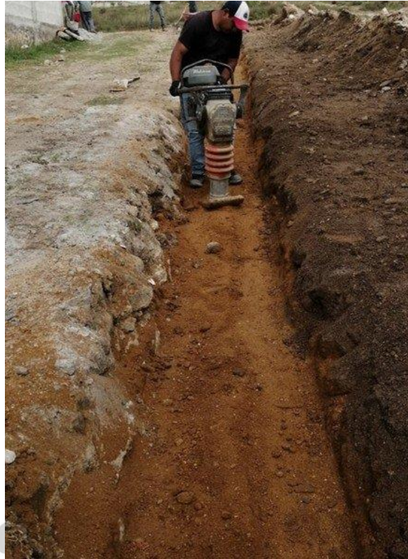
Ilustración 9. Relleno compactado con material de excavación.
