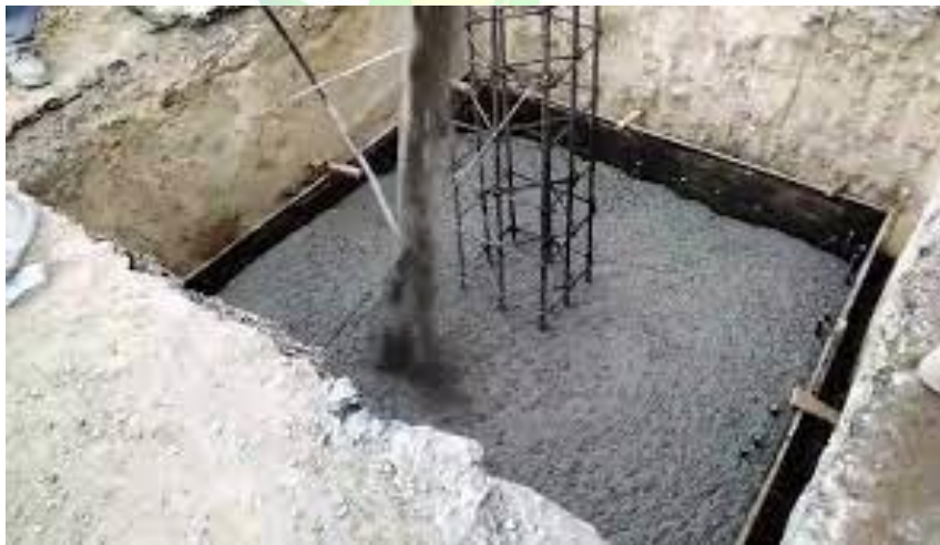
Ilustración 15. Construcción de zapatas en concreto.
