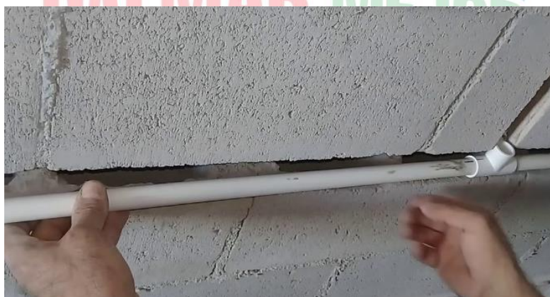
Ilustración 76. instalación tubería de 1/2".
