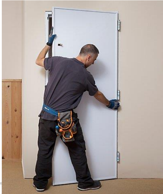
Ilustración 86. Instalación de puertas.
