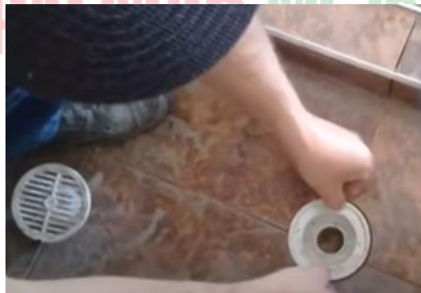
Ilustración 68. instalación de rejilla.
