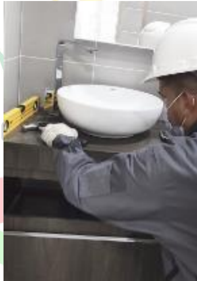
Ilustración 65. instalación de lavamanos.
