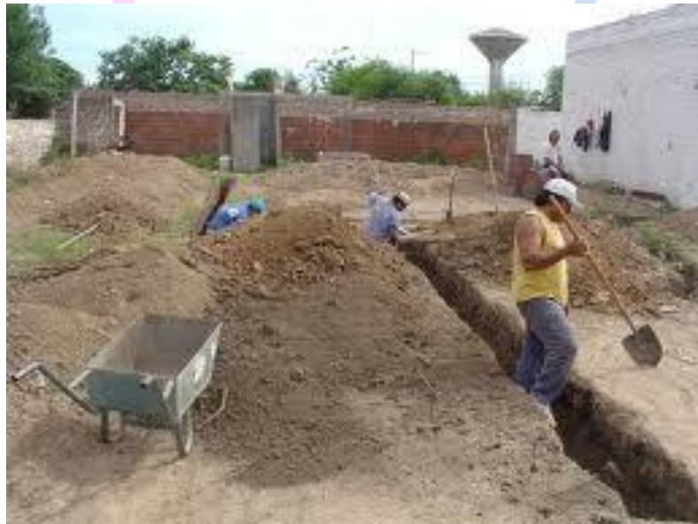
Ilustración 5. Excavación material común.
