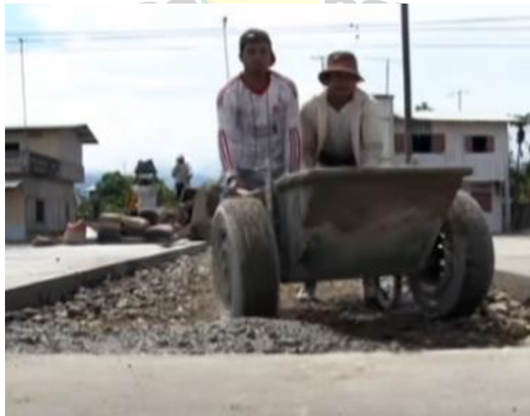
Ilustración 50. Construcción de losa de concreto de la cancha.
