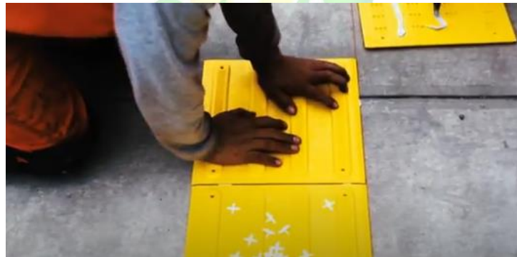
Ilustración 88. instalación losas piso táctiles.
