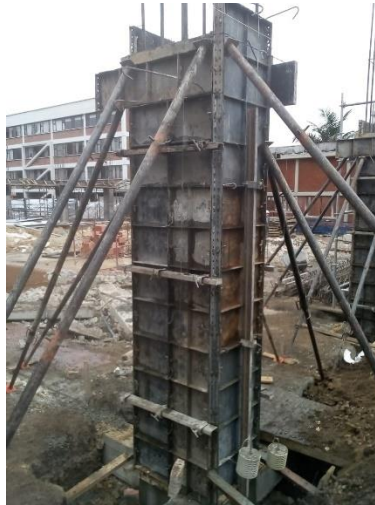
Ilustración 18. Construcción de columnas en concreto.
