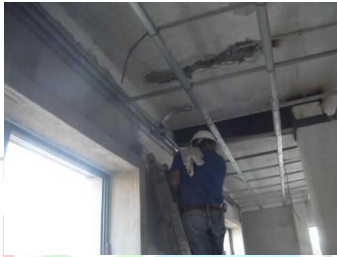
Ilustración 61. Instalación tubería EMT.
