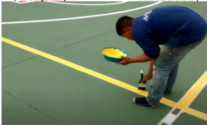
Ilustración 54. Pintura de demarcación de canchas.
