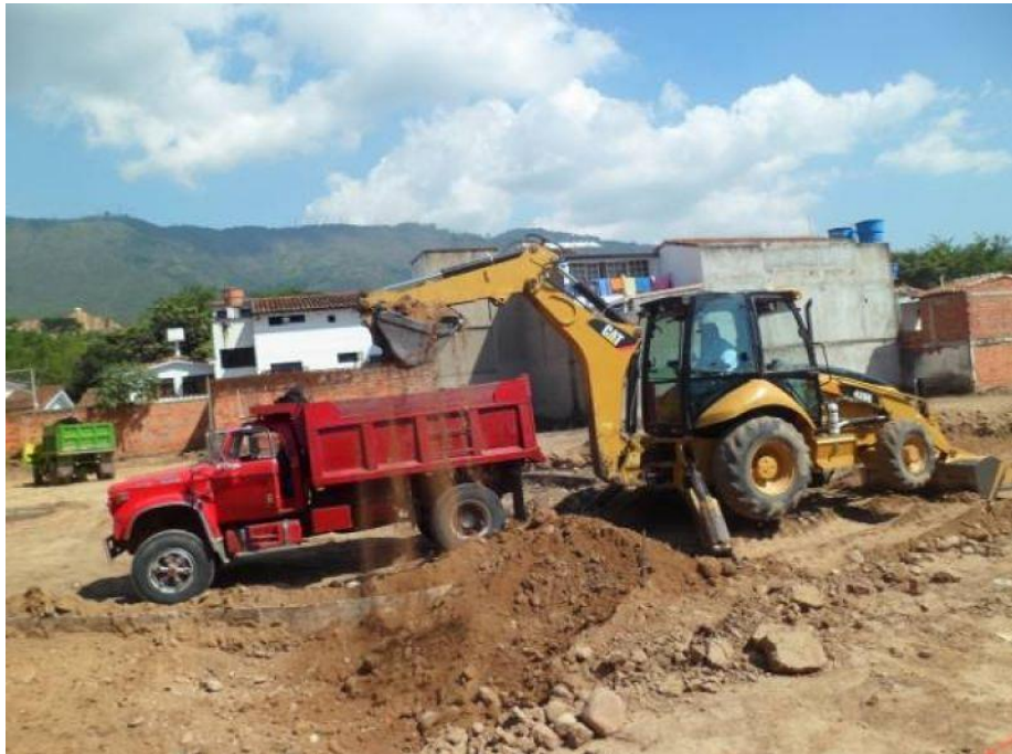
Ilustración 11. Retiro de material producto de las excavaciones.
