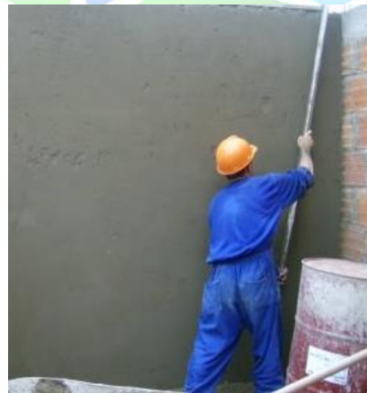
Ilustración 45. Friso sobre muro en mortero.
