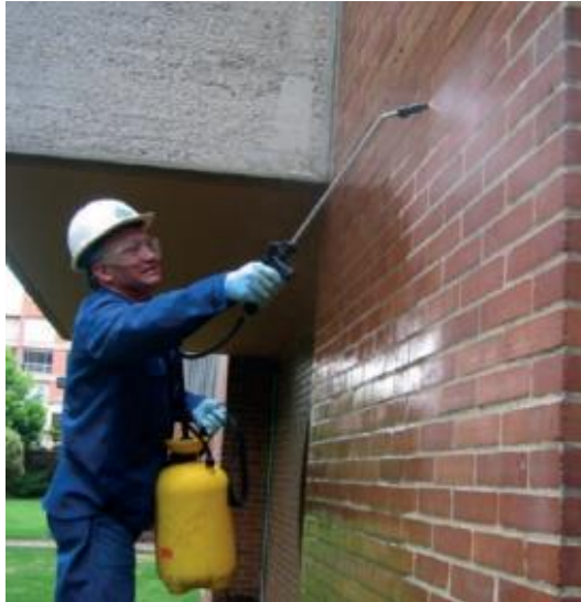
Ilustración 96. Lavado e hidrofraguado.
