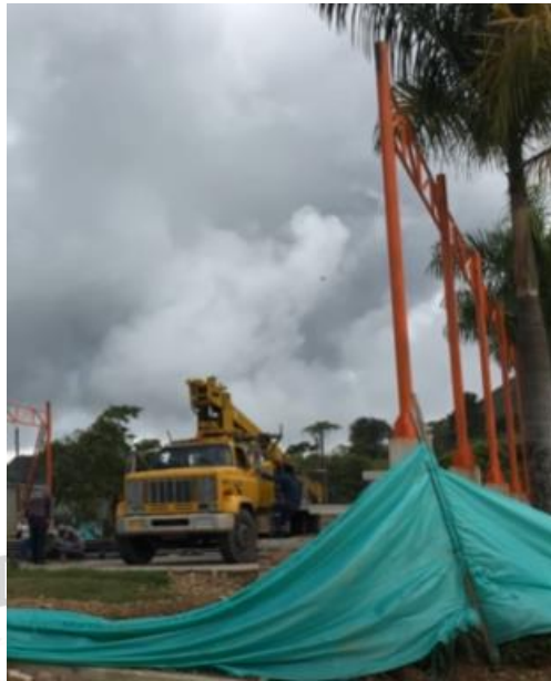
Ilustración 36.Montaje cerchas laterales.
