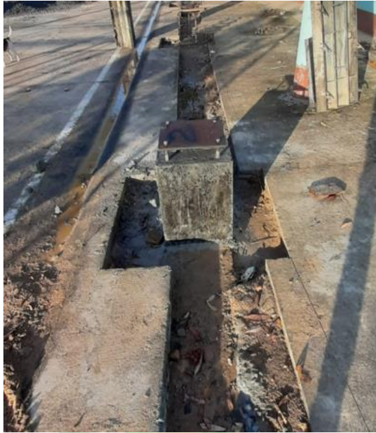
Ilustración 17. Construcción de pedestales en concreto.
