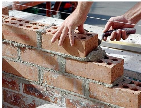
Ilustración 42. Mampostería a la vista.
