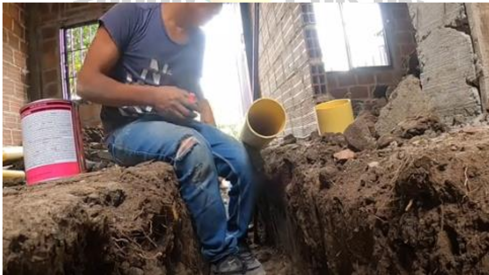
Ilustración 73. instalación de tubería sanitaria.
