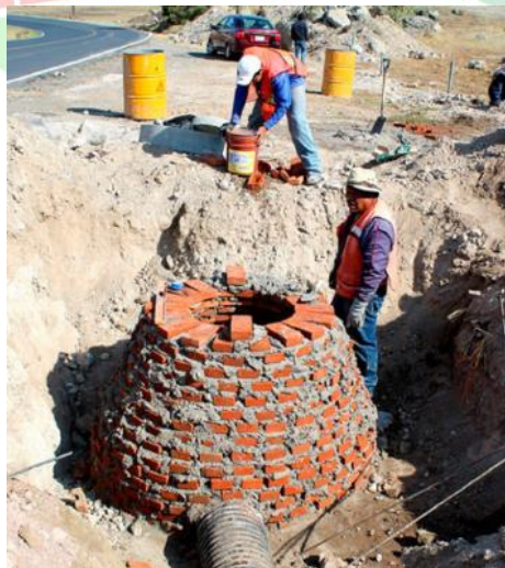
Ilustración 83. Construcción pozo inspección
