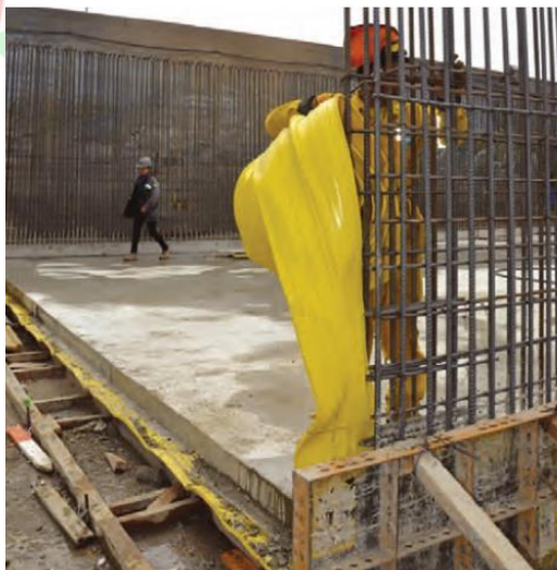
Ilustración 31. Instalación de cinta PVC.
