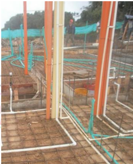
Ilustración 82. instalación tubería de reventilacion.
