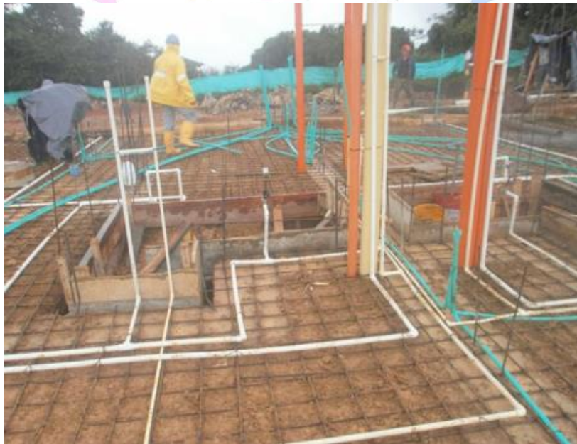
Ilustración 77. Instalaciones hidráulicas.
