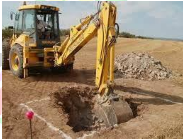
Ilustración 6. Excavación mecánica material común.
