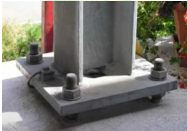
Ilustración 37. Instalación de columna metálica con placa base al pedestal en concreto.
