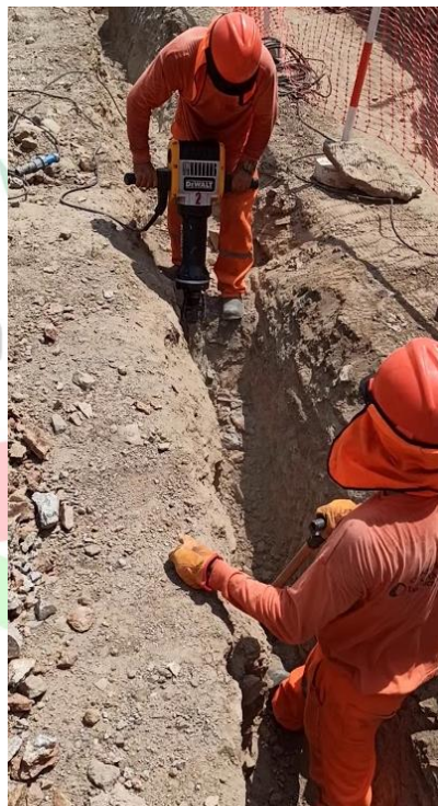
Ilustración 90. Excavación en roca.
