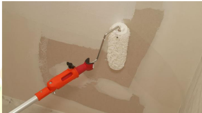
Ilustración 49. Estuco y pintura.
