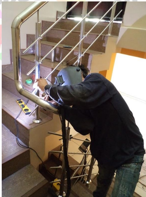
Ilustración 85. Instalación de barandas.
