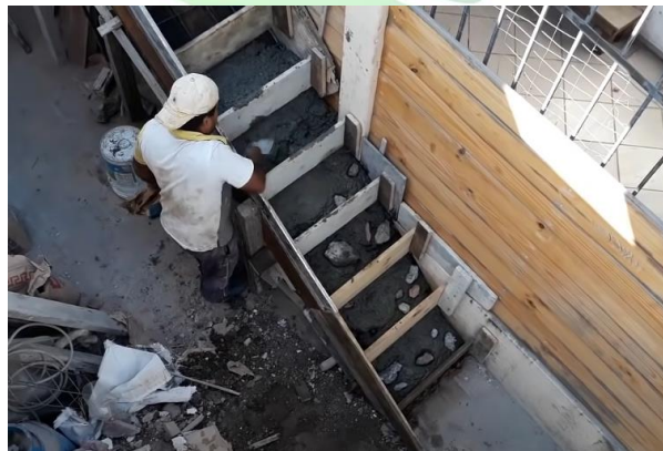
Ilustración 22. Construcción de escaleras.
