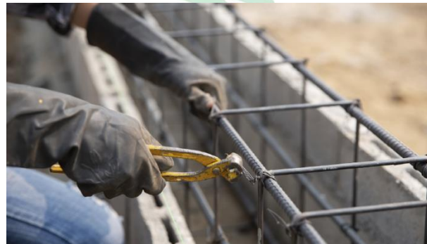
Ilustración 27. Suministro e instalación de acero de refuerzo f_y=60000 PSI
