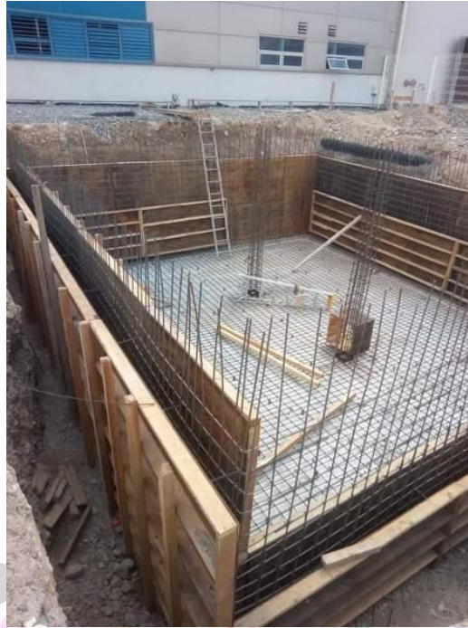
Ilustración 29. Construcción de tanque en concreto.
