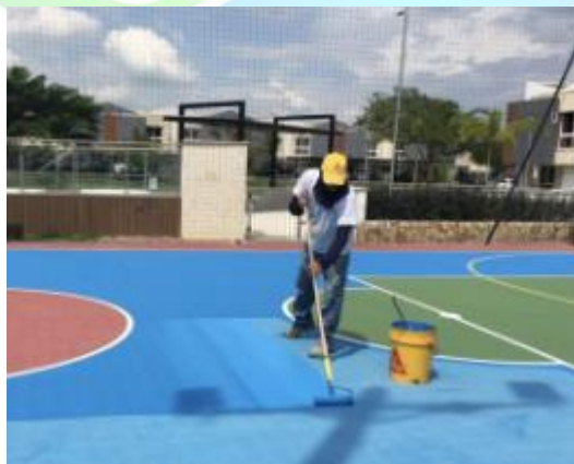
Ilustración 53. Pintura acrílica para cancha.
