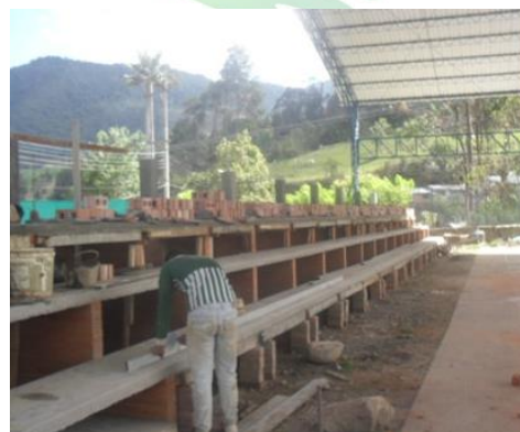
Ilustración 21. Construcción de gradería.
