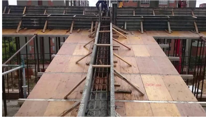
Ilustración 19. Construcción de vigas en concreto.
