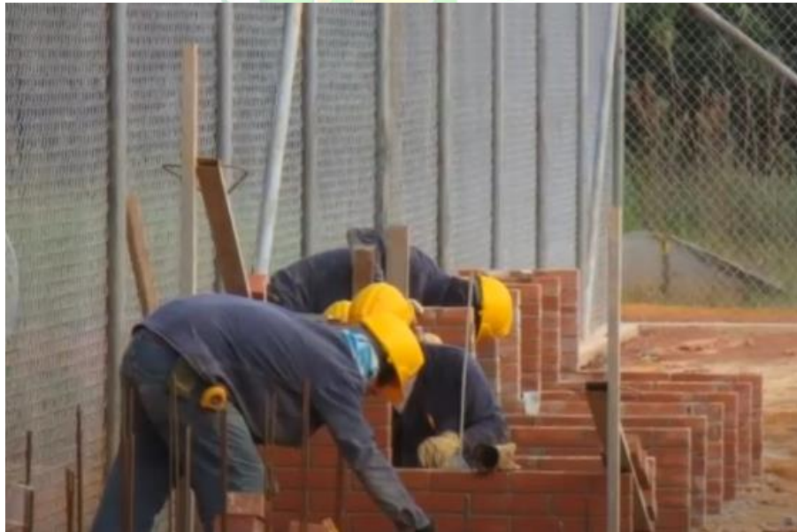
Ilustración 41. Mampostería estructural gradería.
