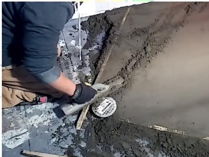
Ilustración 43. Mortero de nivelación de baños.
