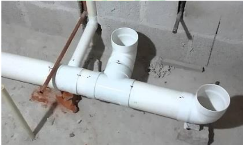
Ilustración 30. Instalación punto desagüe de 4" para tanque.
