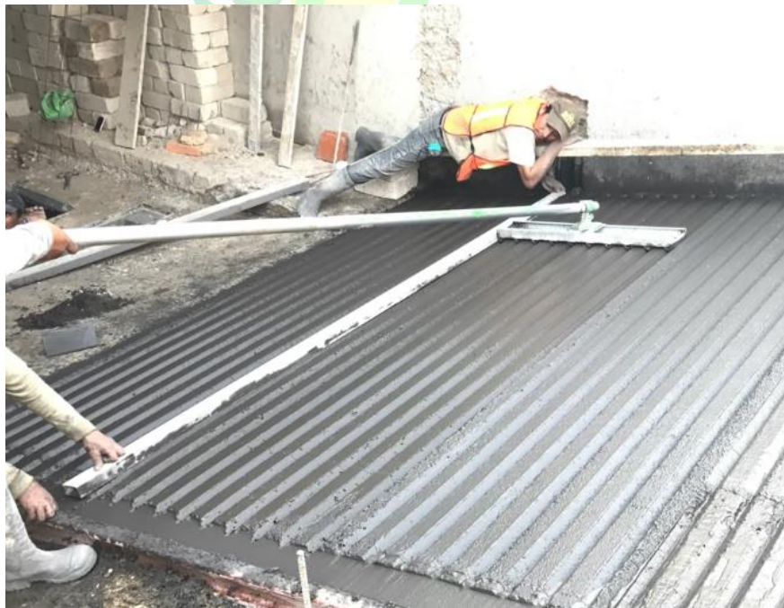
Ilustración 25. Rampa en concreto.
