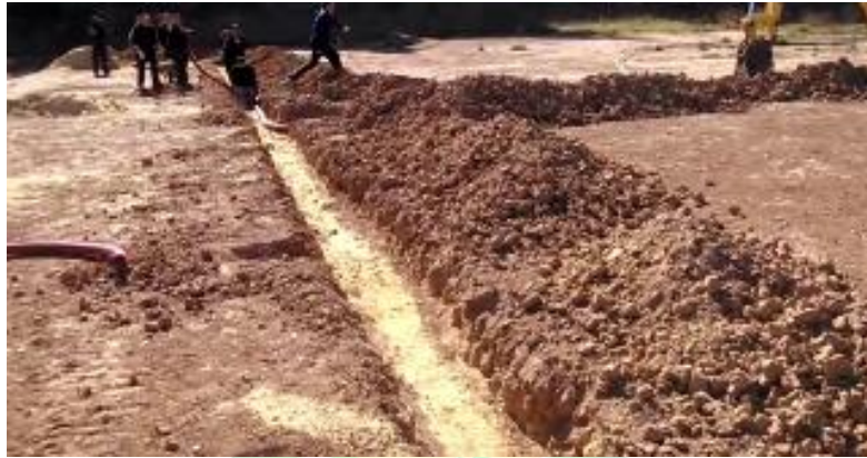
Ilustración 69. Arena para cimentación de tubería.
