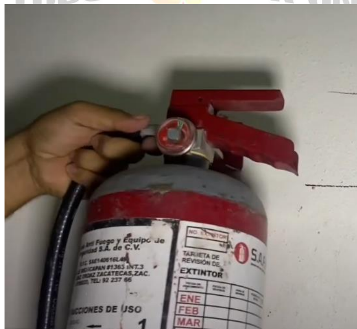
Ilustración 98. instalación de extintor.
