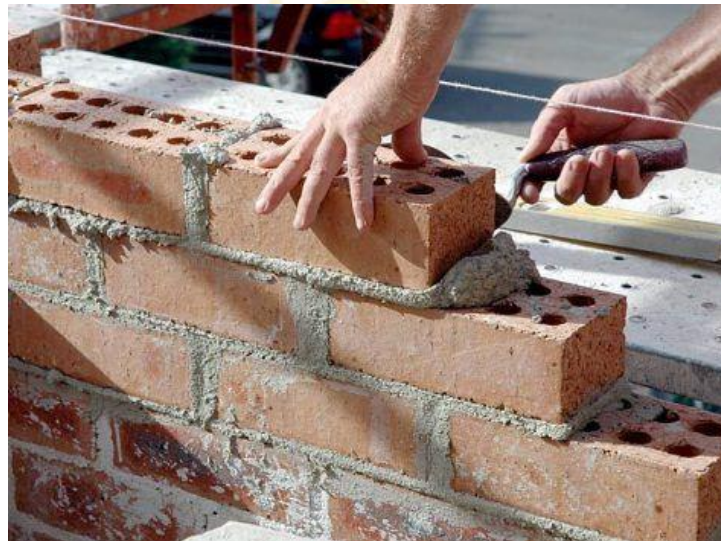
Ilustración 95. Construcción de muro.
