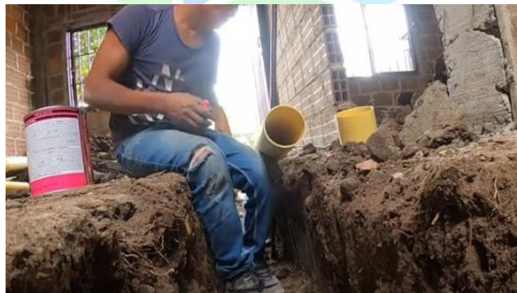
Ilustración 81. instalación tubería sanitaria.
