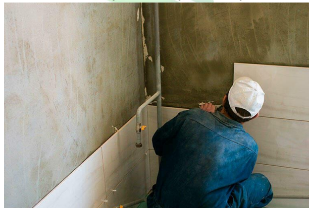
Ilustración 47. Instalación enchape de pared de baños.
