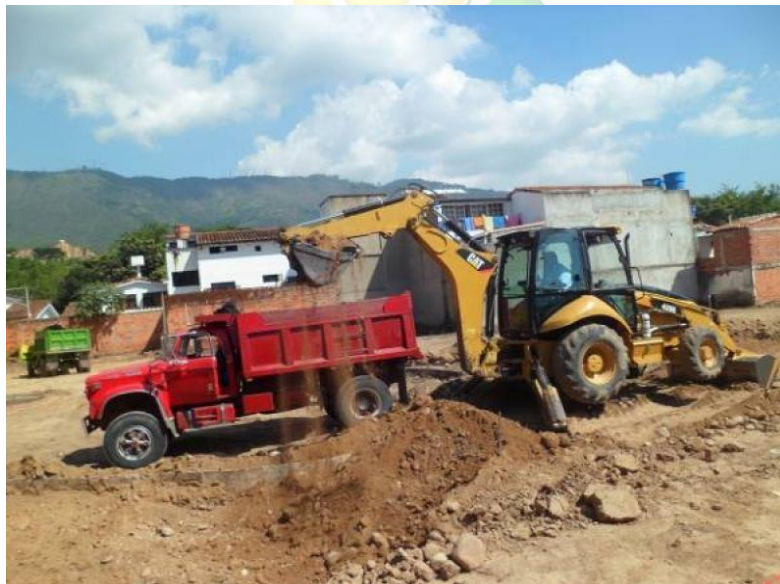
Ilustración 91. Retiro de material producto de las excavaciones.
