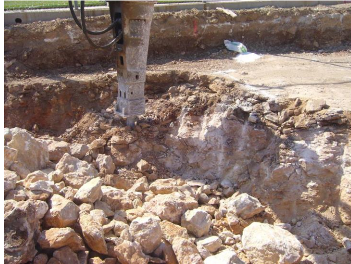
Ilustración 8. Excavación mecánica en roca.
