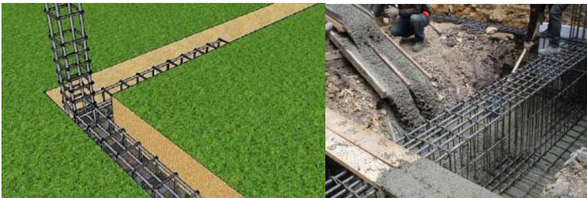
Ilustración 16. Construcción de vigas de cimentación.
