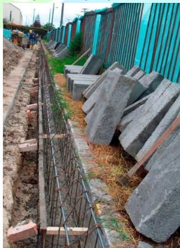
Ilustración 94. Construcción viga corrida en concreto.
