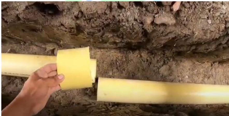
Ilustración 75. instalación tubería sanitaria.
