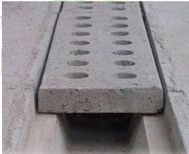
Ilustración 24. Construcción de cárcamo en concreto.
