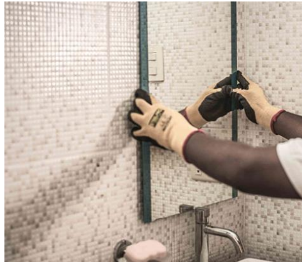
Ilustración 67. instalación de espejos.
