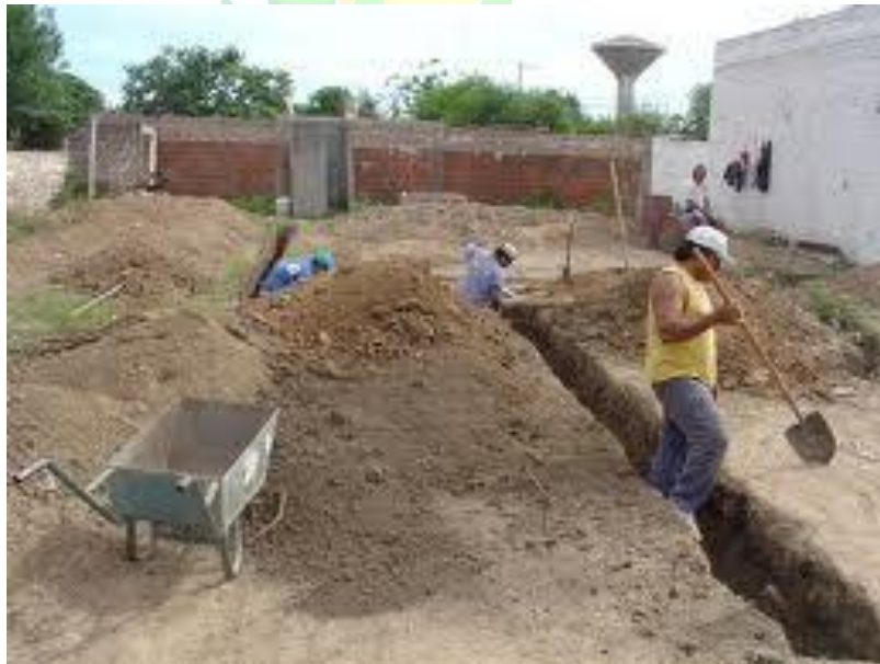
Ilustración 89. Excavación material común.
