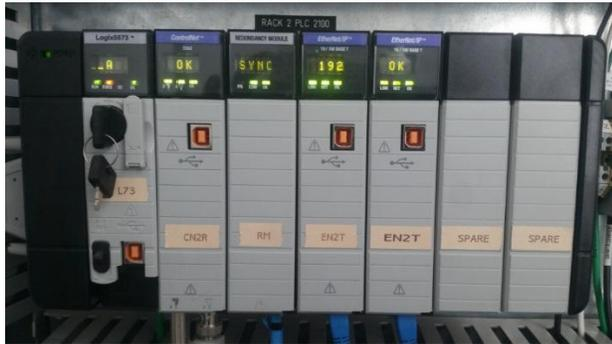
El modelo presentado propone la siguiente arquitectura de control en el cual la redundancia de equipos críticos tales como: Controladores, servidores, clientes, switches y computador de flujo son pieza fundamental basada en redundancia para conseguir operar, administrar y mantener una unidad LACT tolerante a fallas.
