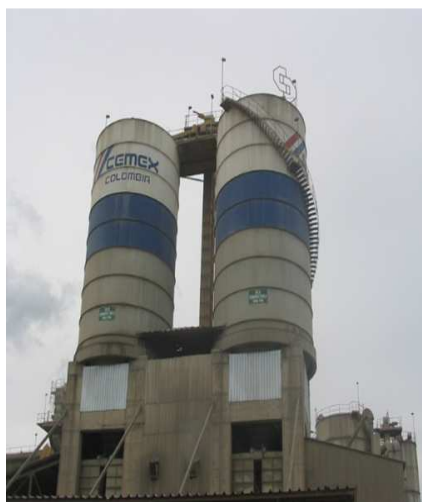
Figura 7. Silo de Almacenamiento [3]
