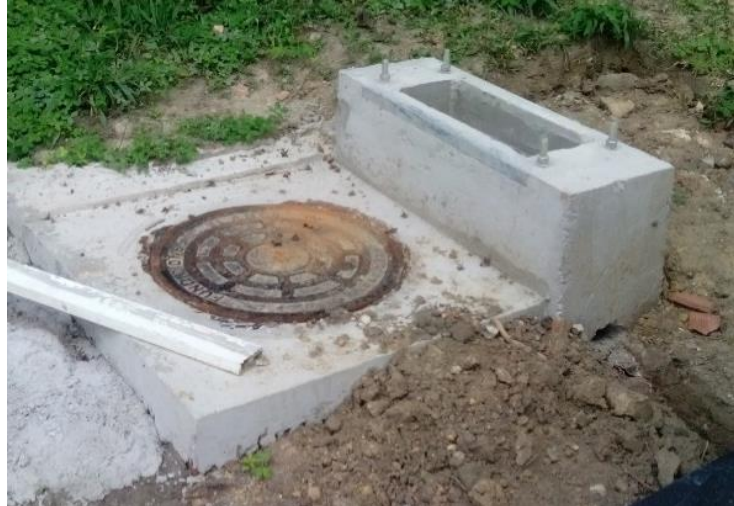
Fotografía 6. Fundamento y cámara F.
