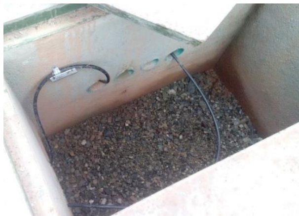
Fotografía 15. Filtro en el fondo de la cámara.
