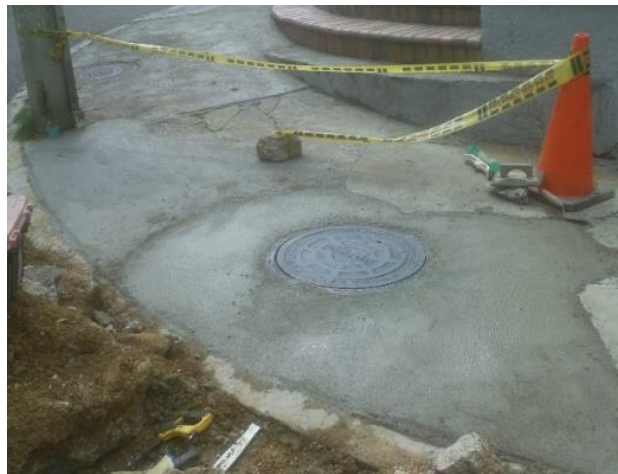
Fotografía 19. Reposición de andén en concreto.
