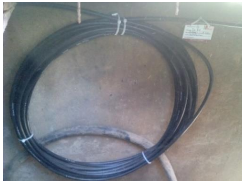
Fotografía 25. Colocación de reserva de F.O en el interior de la cámara.
