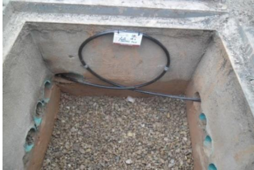
Fotografía 25. Colocación de reserva de F.O en el interior de la cámara.
