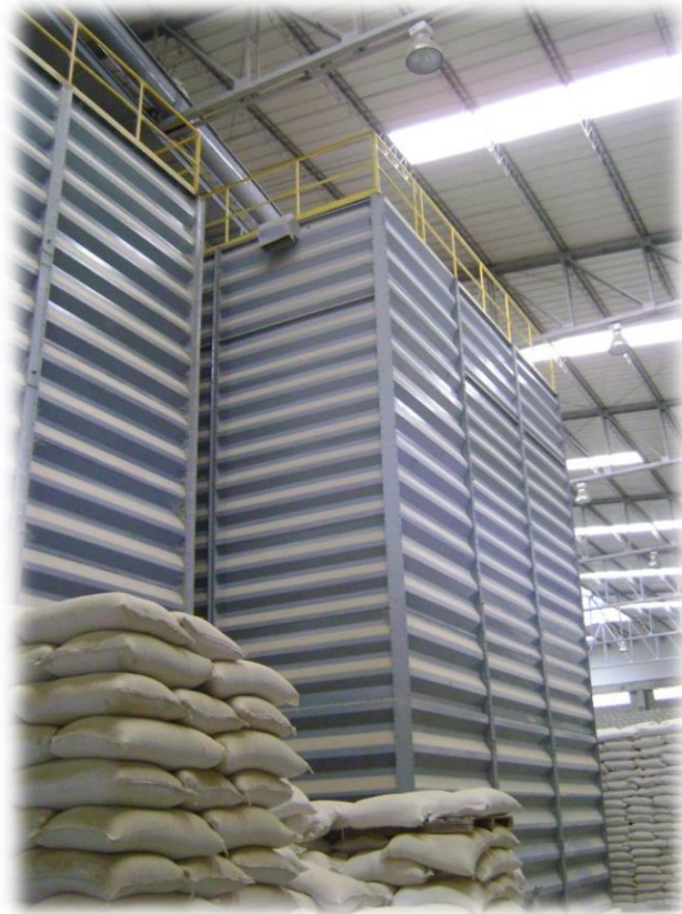
Figura 5 Silos de almacenamiento
