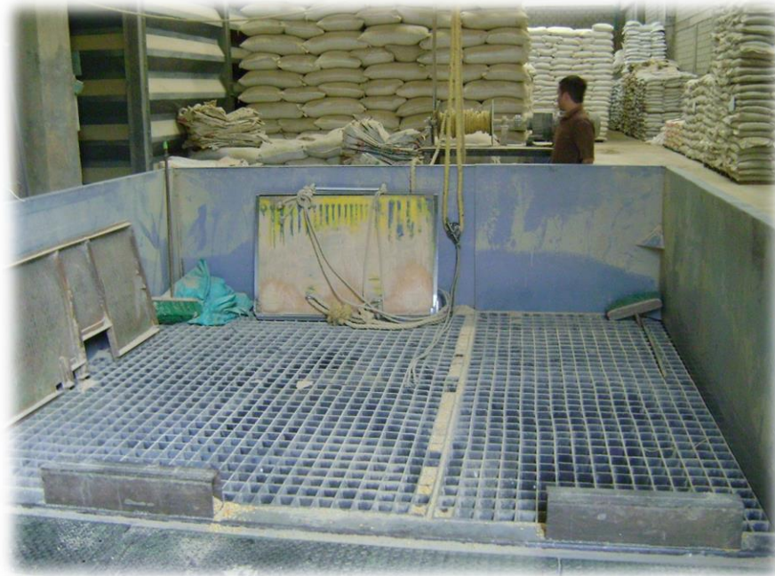
Figura 4 Descargue de materias primas
