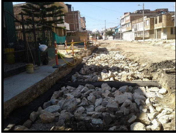
Figura: 35. Instalación de pedraplen.
