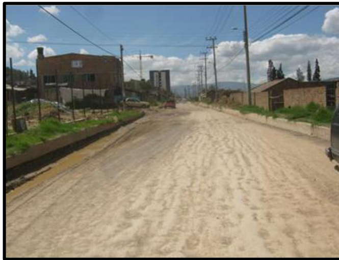
Figura: 9, Tramo en ejecución, Cra 32 entre Calle 7 Y 11.
