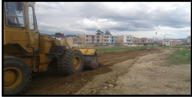
Figura: 26. Disposición de material de excavación.
