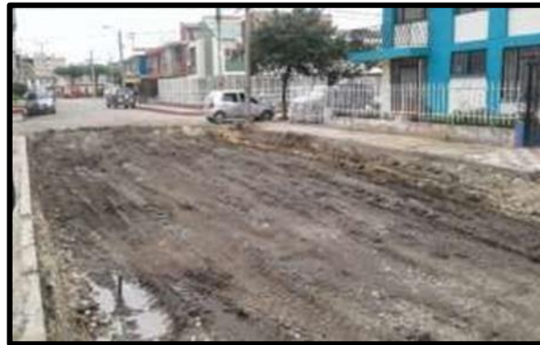
Figura: 24. Figura 4: Trabajos de excavación.
