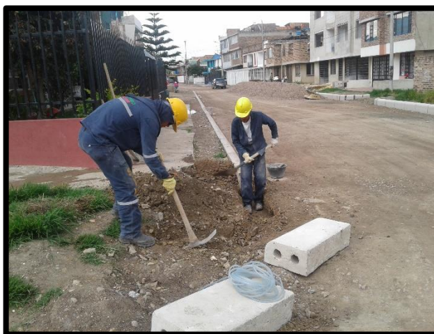
Figura: 42. Instalación de bordillos A-10.
