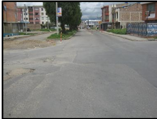
Figura: 17. Tramo en ejecución, Cra 8 entre Calles 4 Y 7.
