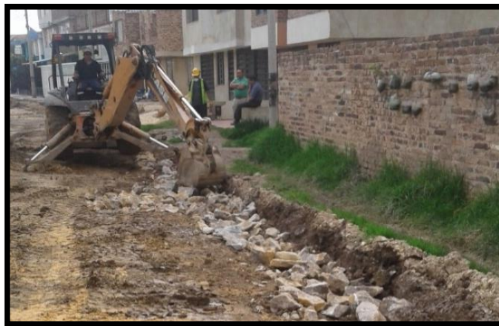
Figura: 28. Instalación pedraplen, carril oriental.
