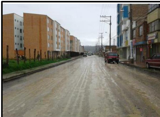
Figura: 15 Tramo sin intervenir, Calle 1 entre Cra 11 Y 13
