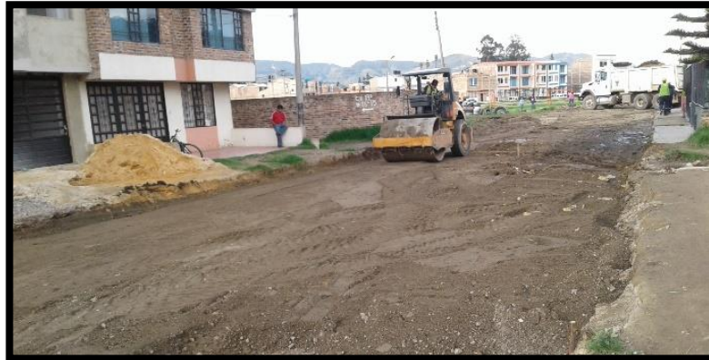
Figura: 27. Trabajos de instalación de Subbase granular.
