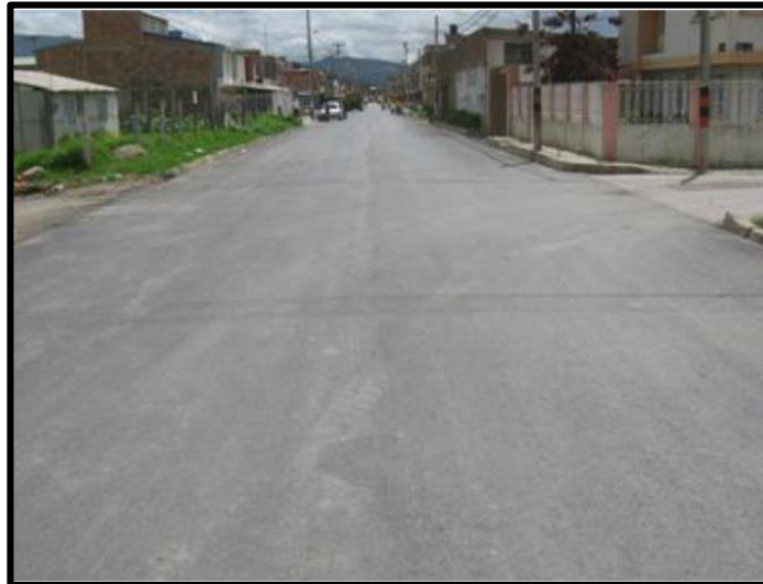
Figura: 6 Tramo ejecutado, Cra 28 entre Calles 1 A 5a.
