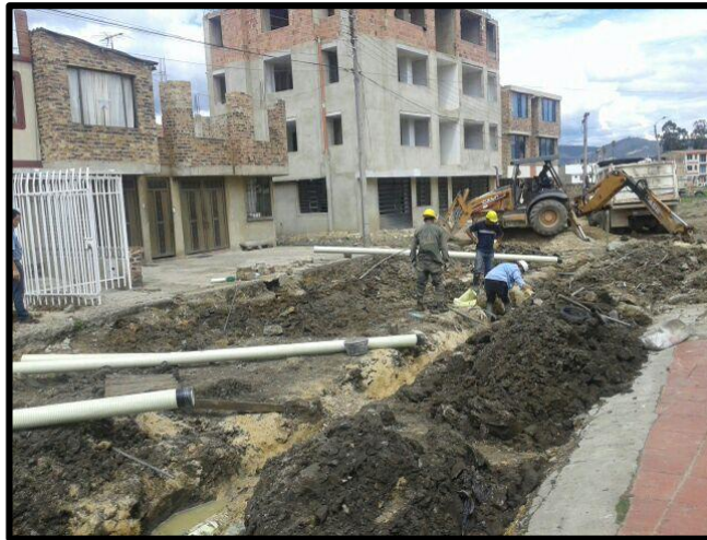
Figura: 36. Instalación de alcantarillado.
