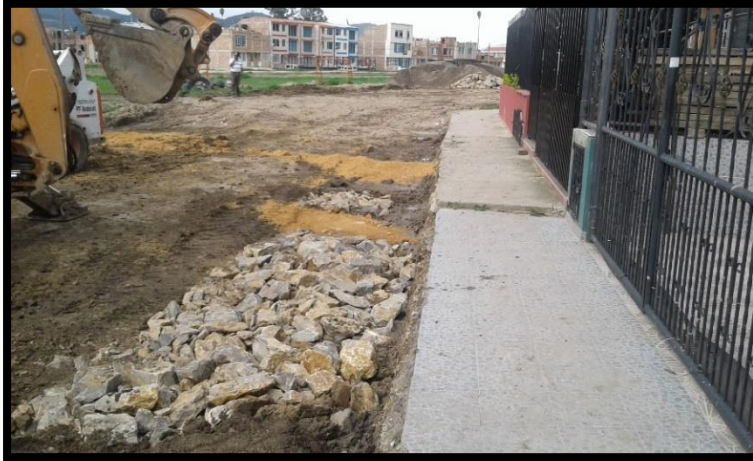
Figura: 29. Instalación pedraplen, carril occidental.
