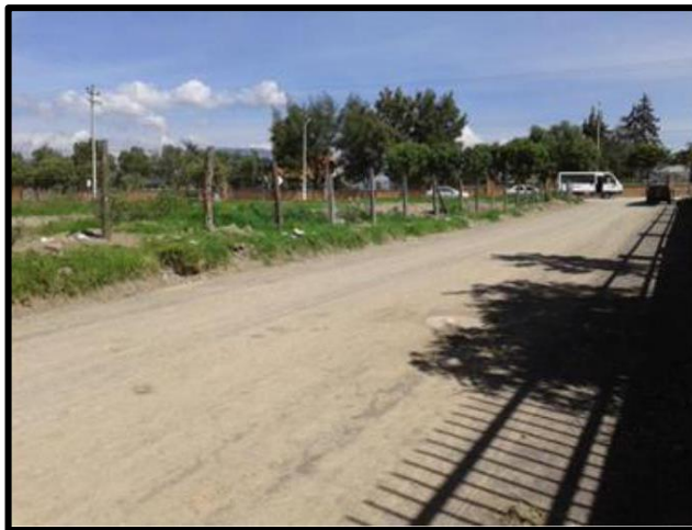
Figura: 12 Tramo en ejecución, Cra 17 entre Calles 3 Sur Y 6 Sur.
