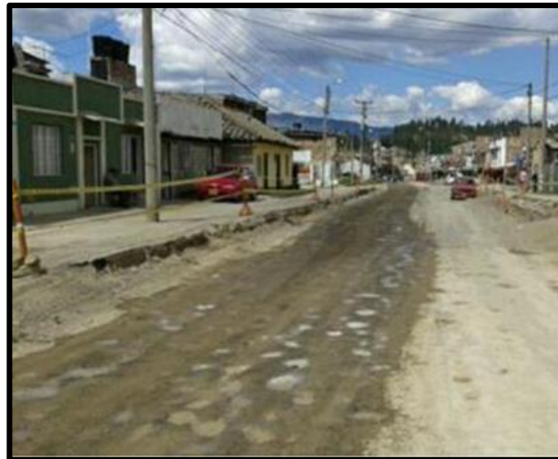
Figura: 11 Tramo en ejecución, Cra 4 entre Calles 1c Y 5.
