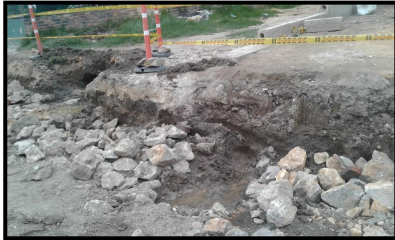
Figura: 31. Excavación para la verificación de la filtración de agua.
