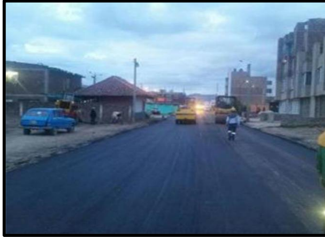
Figura: 14 Tramo ejecutado, Cra 13 entre Calles 1 Y 1b Sur.
