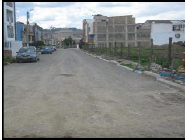
Figura: 13 Tramo ejecutado, calle 4 sur entre Cras 17 y 18
