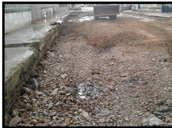
Figura: 41. Instalación pedraplen.
