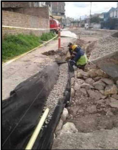
Figura: 34. Instalación de piedra filtro.
