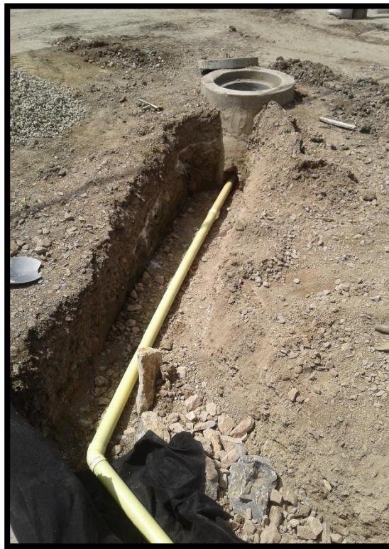
Figura: 43. Dren en piedra filtro y geotextil.
