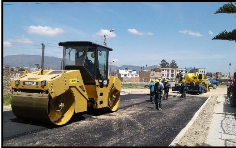
Figura: 46. Instalación de mezcla asfáltica
