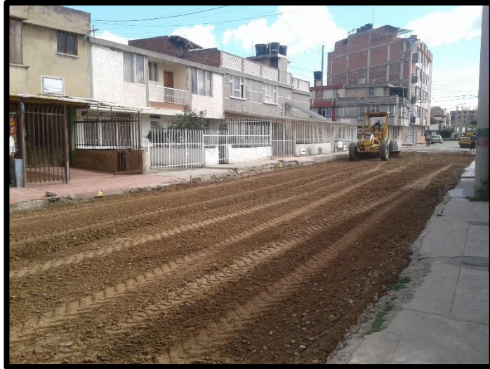
Figura: 44. Conformación base granular
