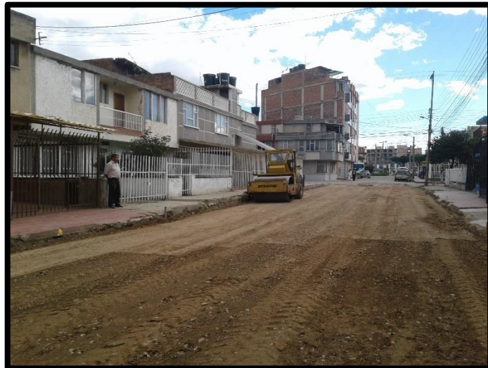
Figura: 45. Compactación base granular.
