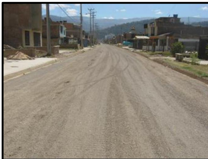
Figura: 7 Tramo en intervención, Calle 1 entre Cra 18 A 28.
