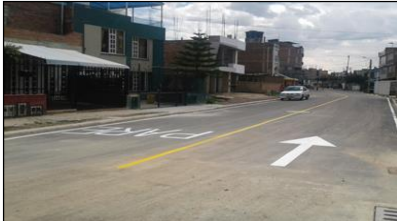
Figura: 47. Demarcación de la vía.
