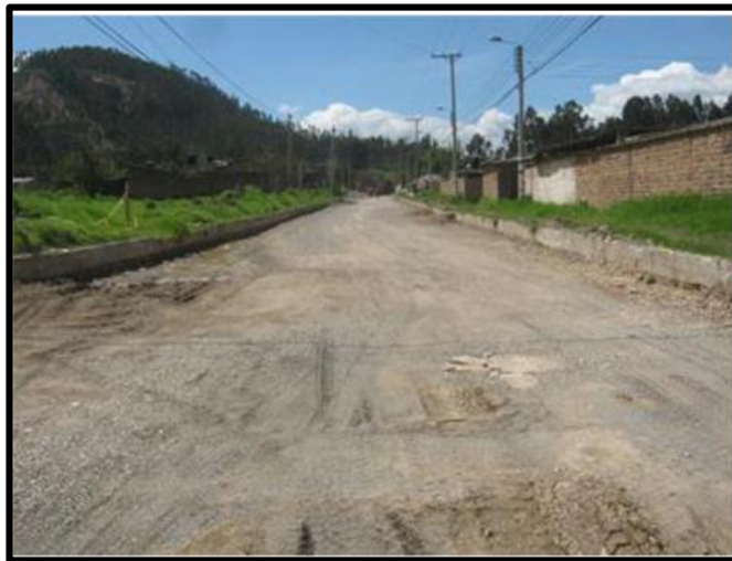
Figura: 10 Tramo en ejecución, Cra 10a entre Calles 40 Y 54
