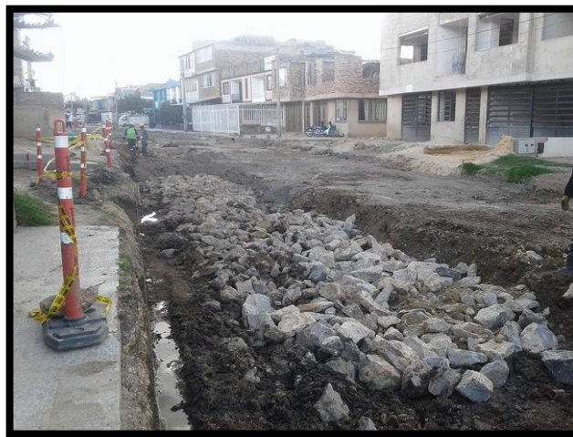
Figura: 32. Zanja para la instalación del dren.
