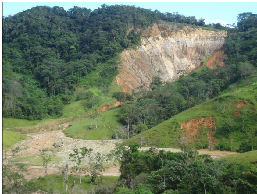
Figura 19. Se muestran dos movimientos en masa de tipo deslizamiento traslacional (parte superior) y flujo de detritos (parte inferior), activos, compuestos y avanzados.
