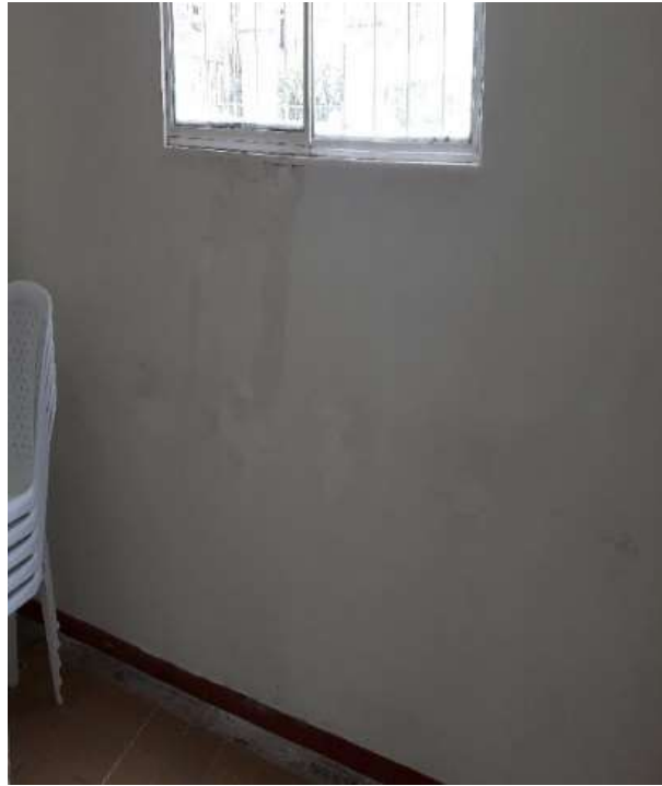
Figura 9, Figura 10. Paredes salón social C.R Villas de San Patricio
