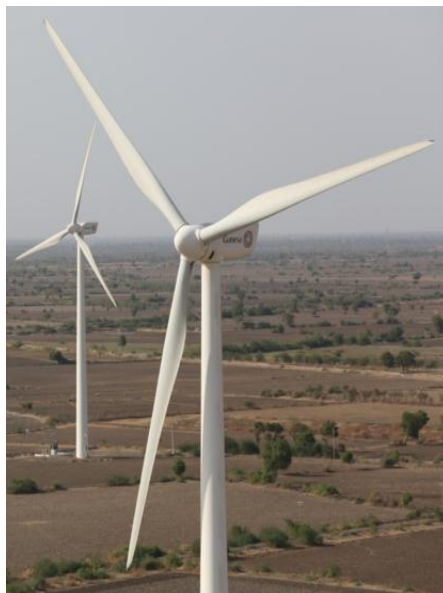
Figura 15. Aerogenerador G97-2.0MW clase S producido por Gamesa[45]
