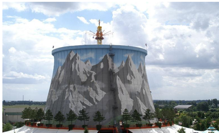
Figura 14. Torre de refrigeración nuclear en el parque Wunderland Kalkar[33]
