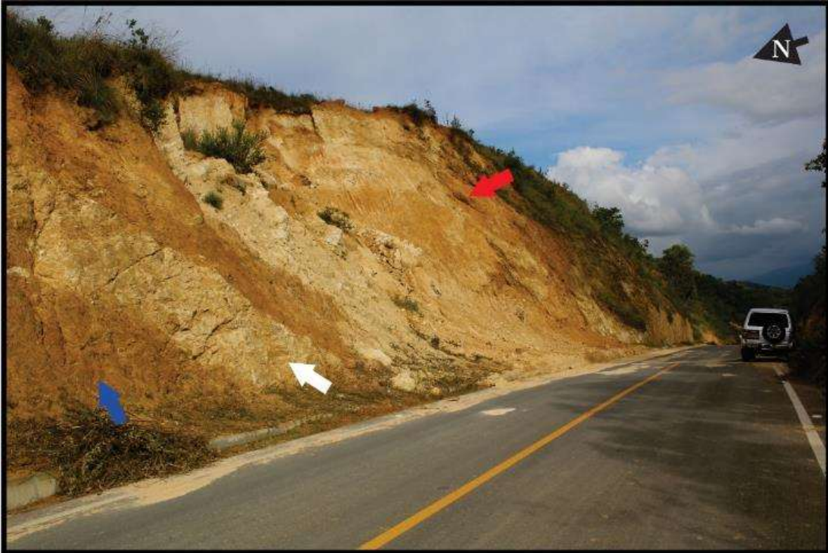
Figura 73. Plano principal Falla Las Lajas (saeta roja) que provoca deslizamientos que obstruyen el paso en esta vía. La saeta blanca señala Leucosoma granítico de inyección que intruye de manera concordante la foliación al Gneis de Bucaramanga (saeta azul).
