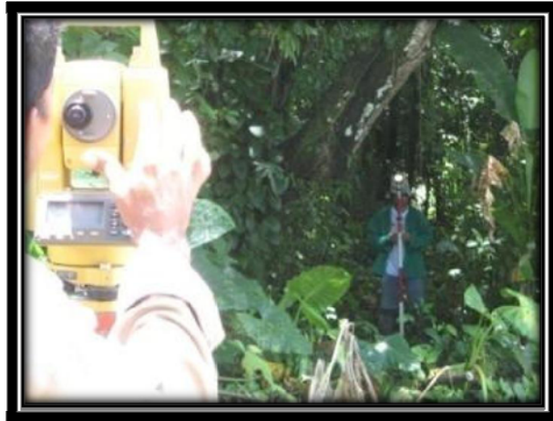
Figura 5. Trabajos topográficos Fuente: Registro fotográfico del proyecto
