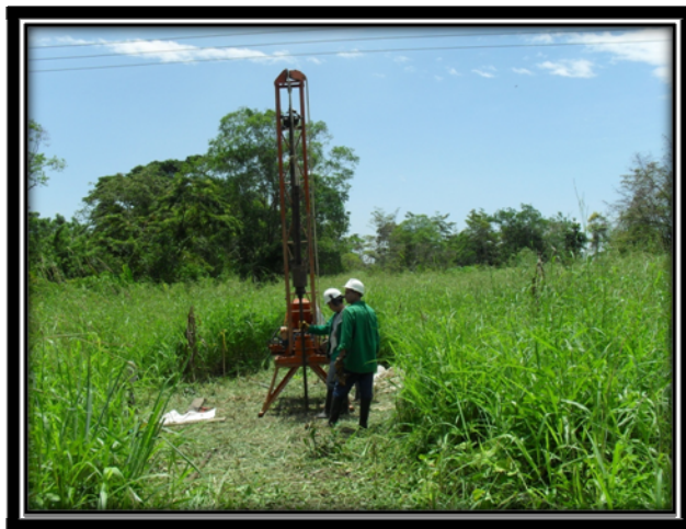
Figura 6. Sondeo cerca Río Pamplonita Fuente: Registro fotográfico del proyecto
