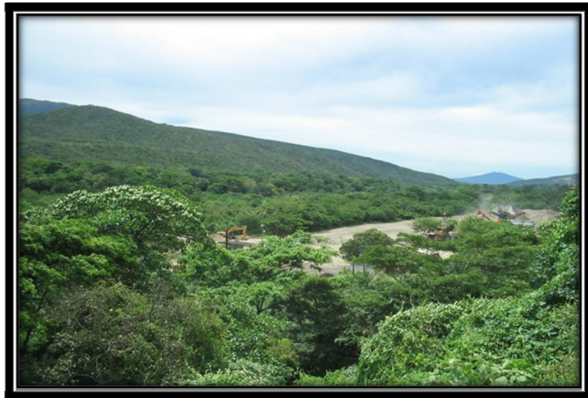
Figura 1. Fuente de Materiales Los Patios, Fuente: Fotos Tomadas por el Ingeniero Residente del proyecto
