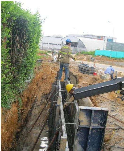
Figura 42. Parales y encofrado muros de contención
