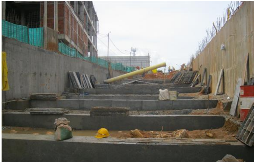
Figura 30. Vigas de amarre
