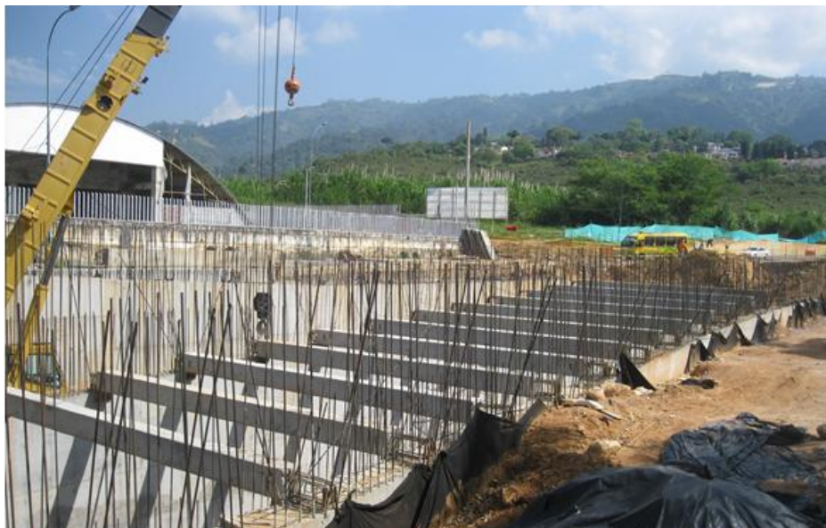
Figura 70. Vista en obra de las vigas intermedias
