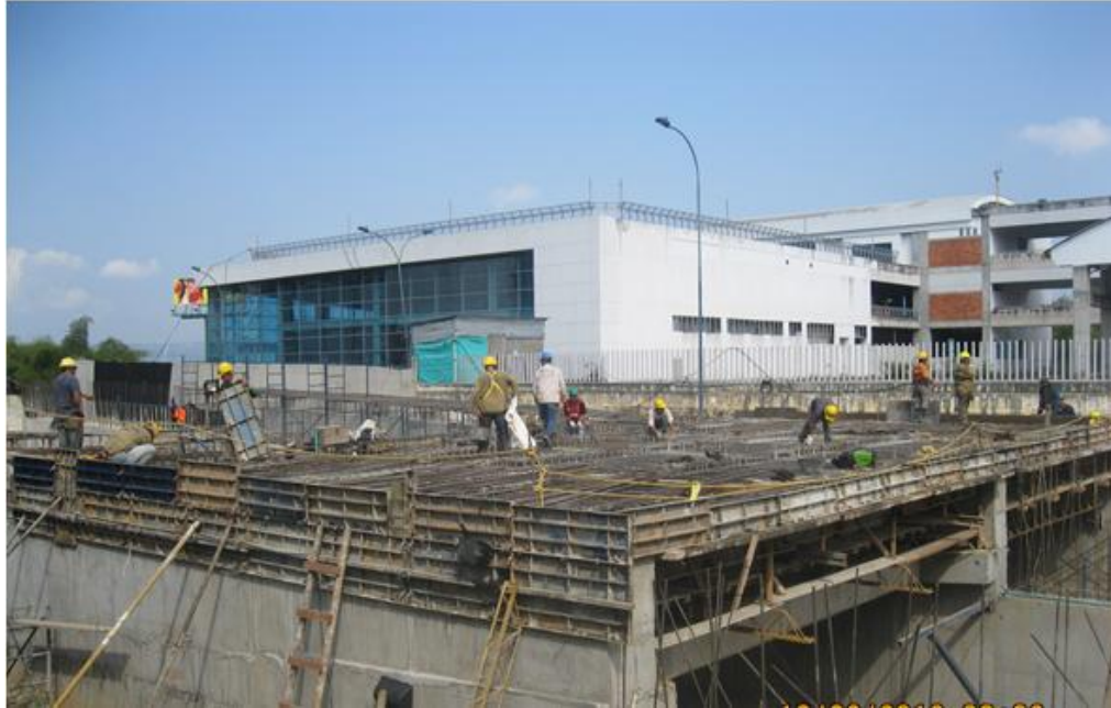
Figura 75. Encofrado de la placa maciza eje 4
