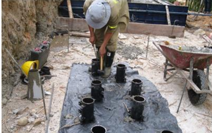
Figura 33. Vaciado de los moldes o camisas con concreto
