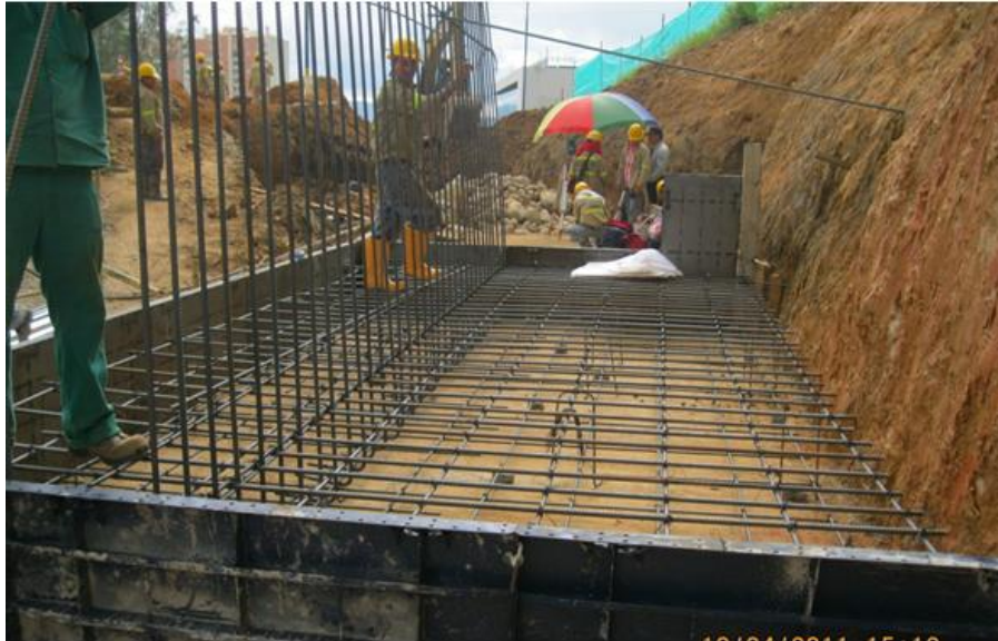
Figura 24. Formaleta metálica para encofrado de la zapatas
