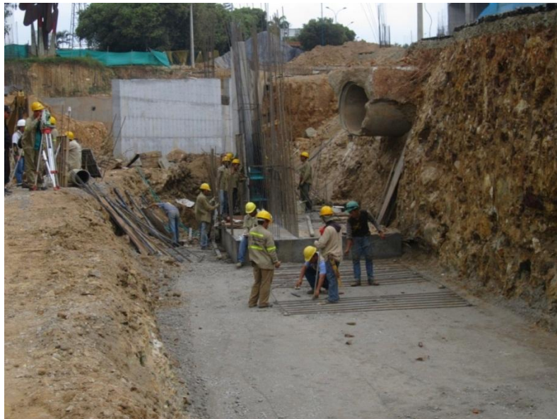
Figura 13. Base estabilizada
