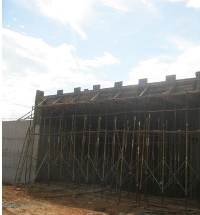
Figura 78. Parales soporte de la formaleta placa aligerada plazoleta
