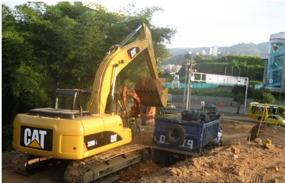
Figura 10. Retroexcavadora y volquetas para sustracción
