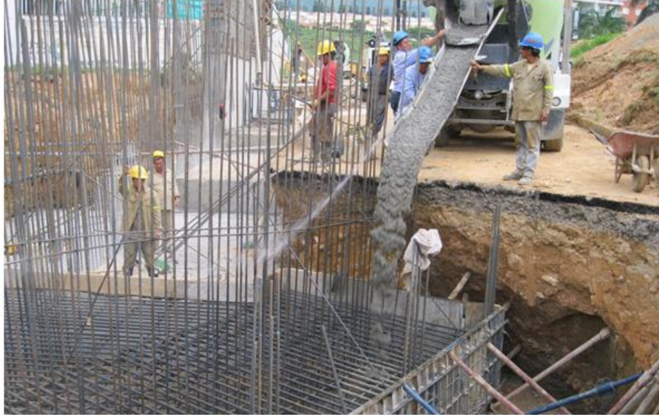
Figura 32. Vaciado del concreto en una zapata
