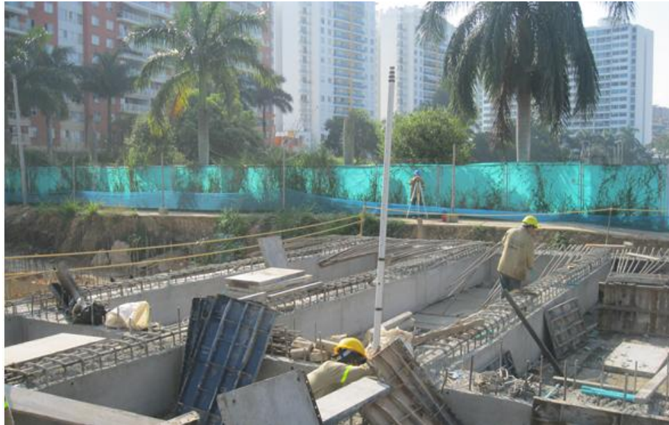
Figura 72. Vista en obra de las vigas superiores
