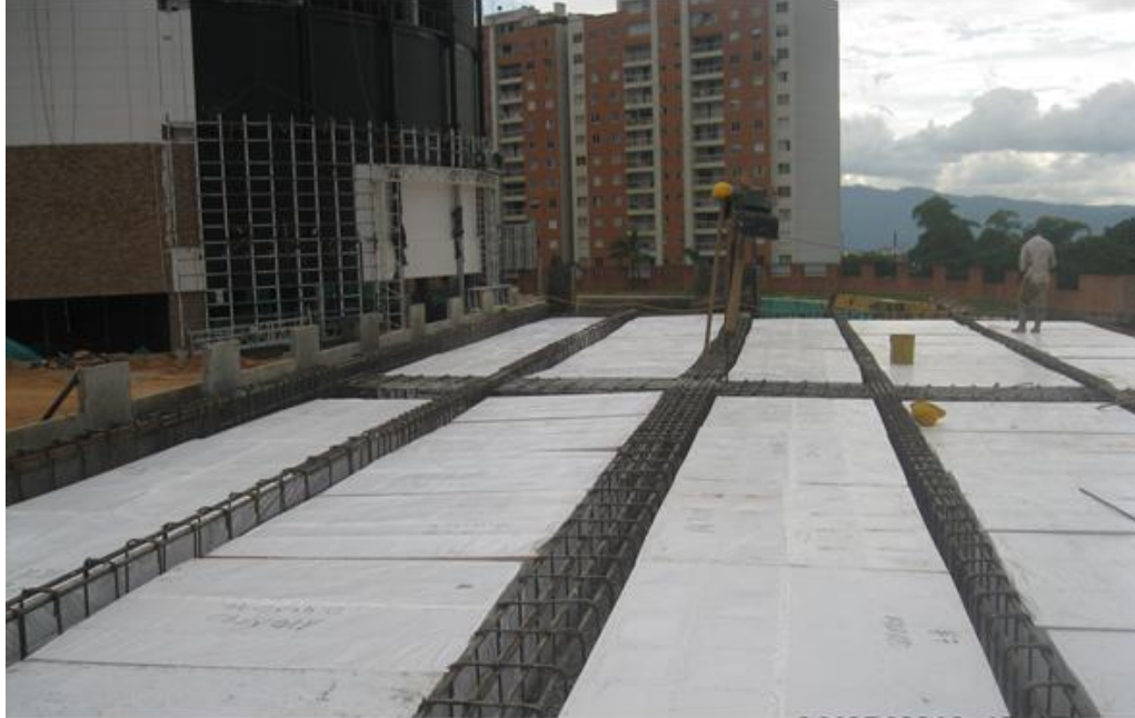
Figura 77. Colocación casetones placa aligerada plazoleta
