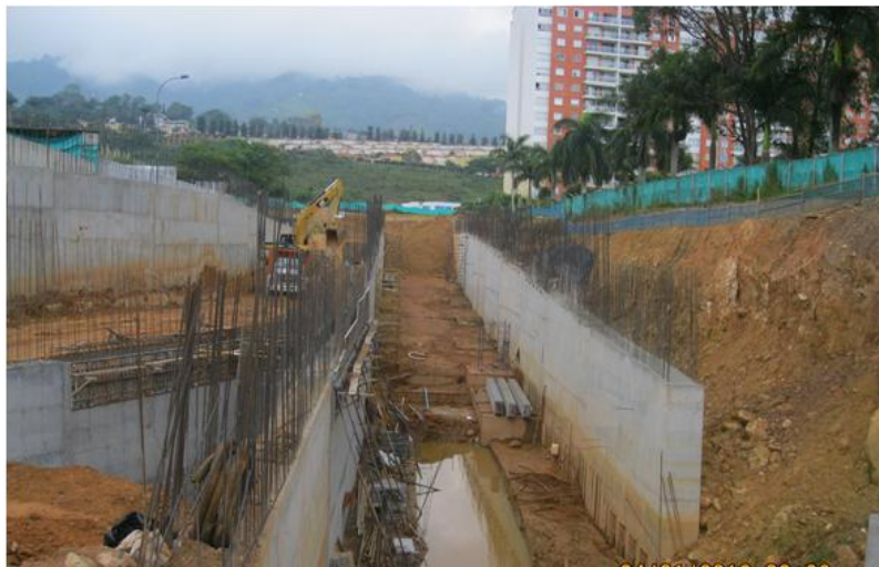
Figura 63. Vista muros MPN eje 4
