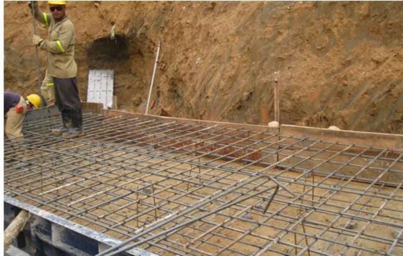
Figura 23. Armadura en acero para zapata
