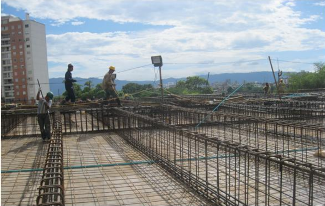
Figura 76. Refuerzo de la placa aligerada plazoleta
