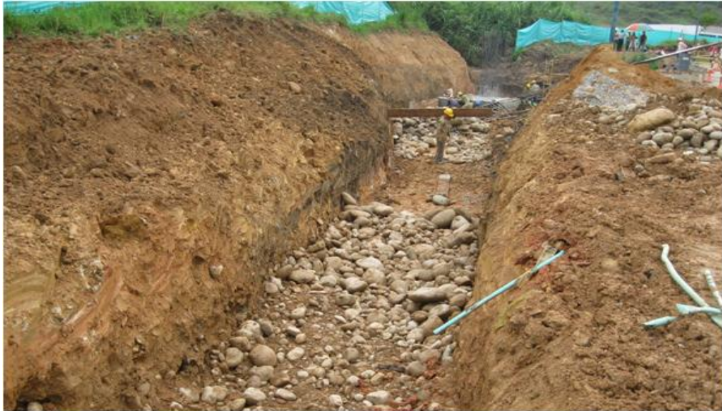
Figura 11. Implementación del Pedraplén
