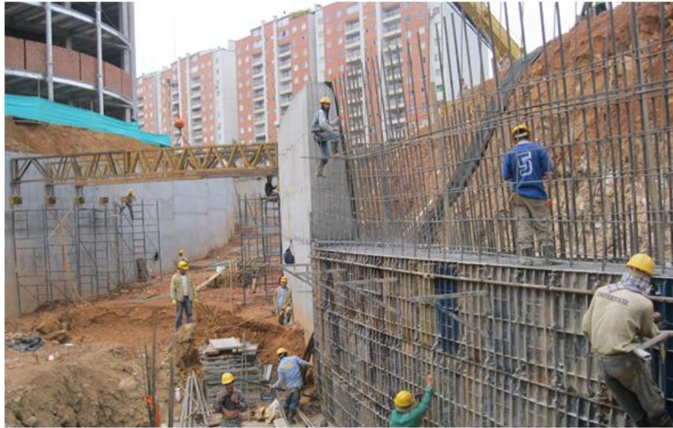
Figura 49. Armadura de acero muros de contención
