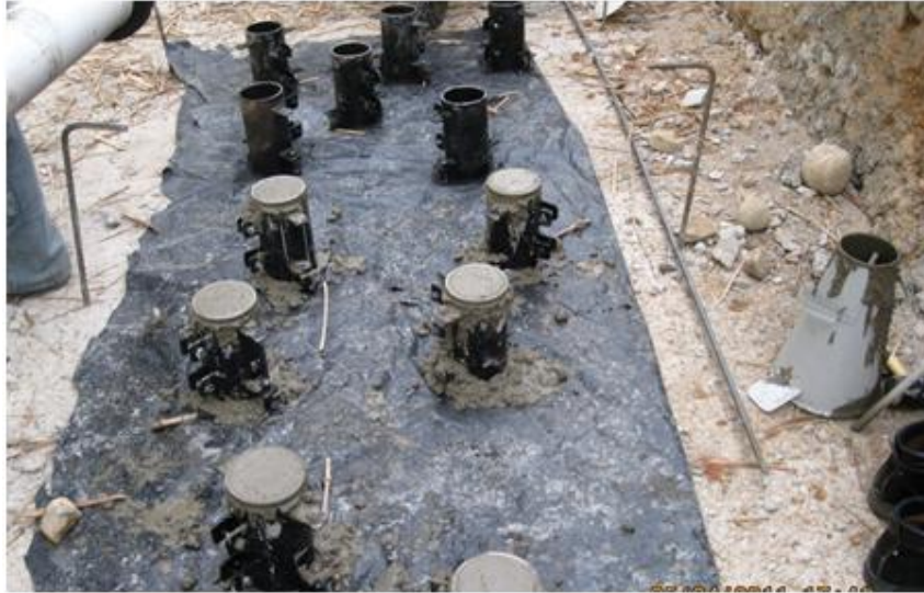
Figura 34. Llenado de las camisas con concreto
