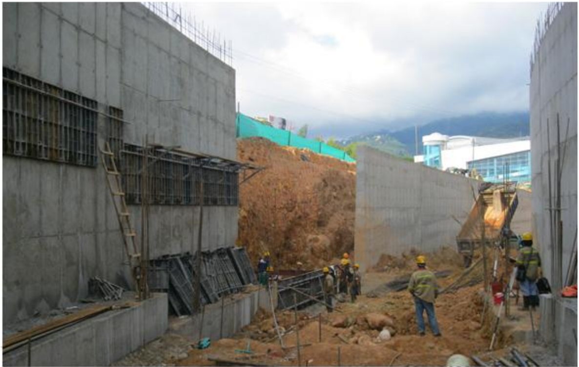
Figura 3. Muros de Contención ubicados en el eje 6
