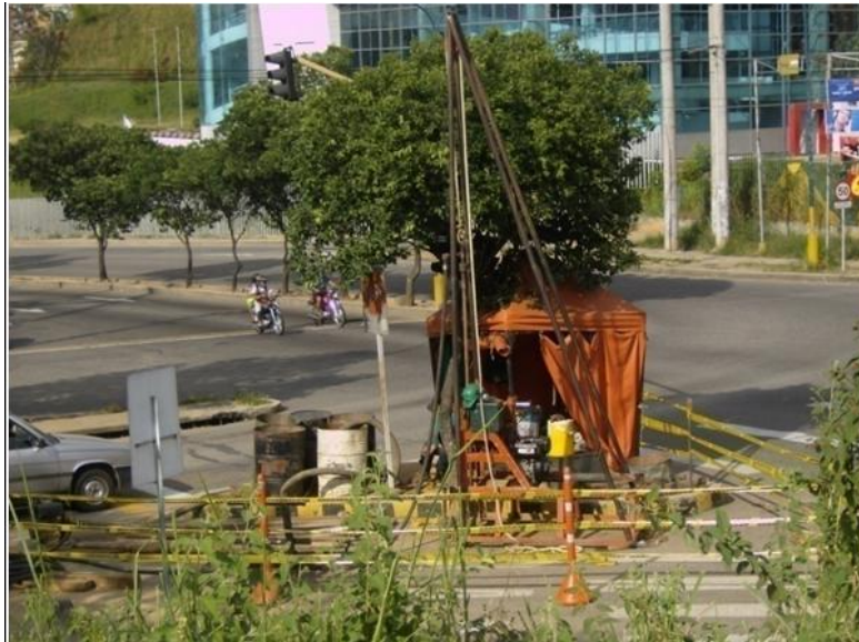
Figura 8. Sondeo tomado en la intersección de la transversal
