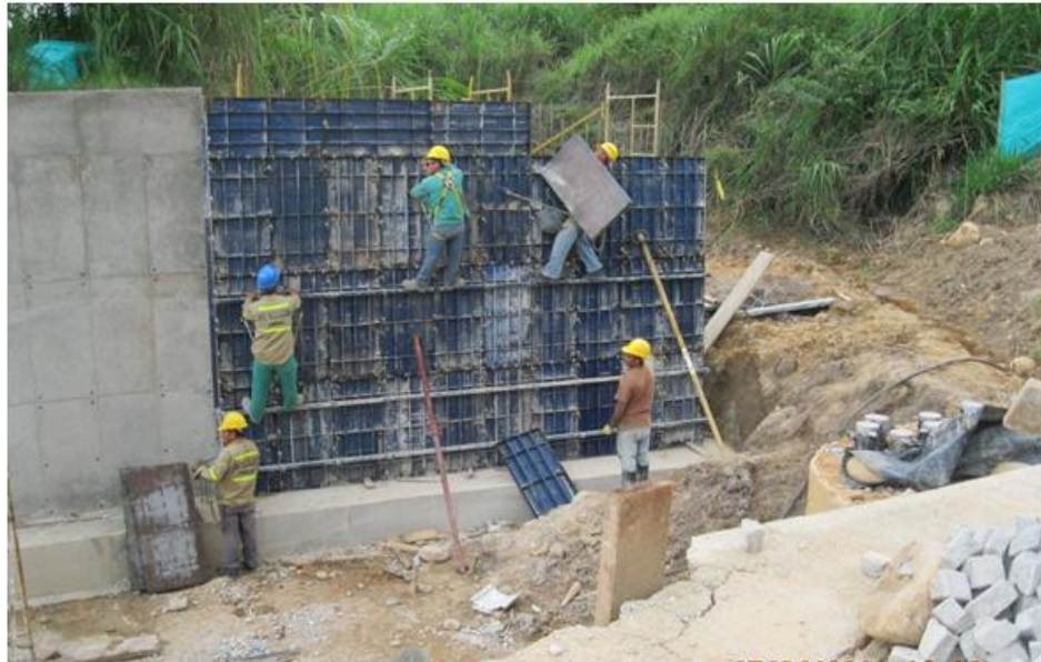
Figura 43. Formaleta para muros de contención
