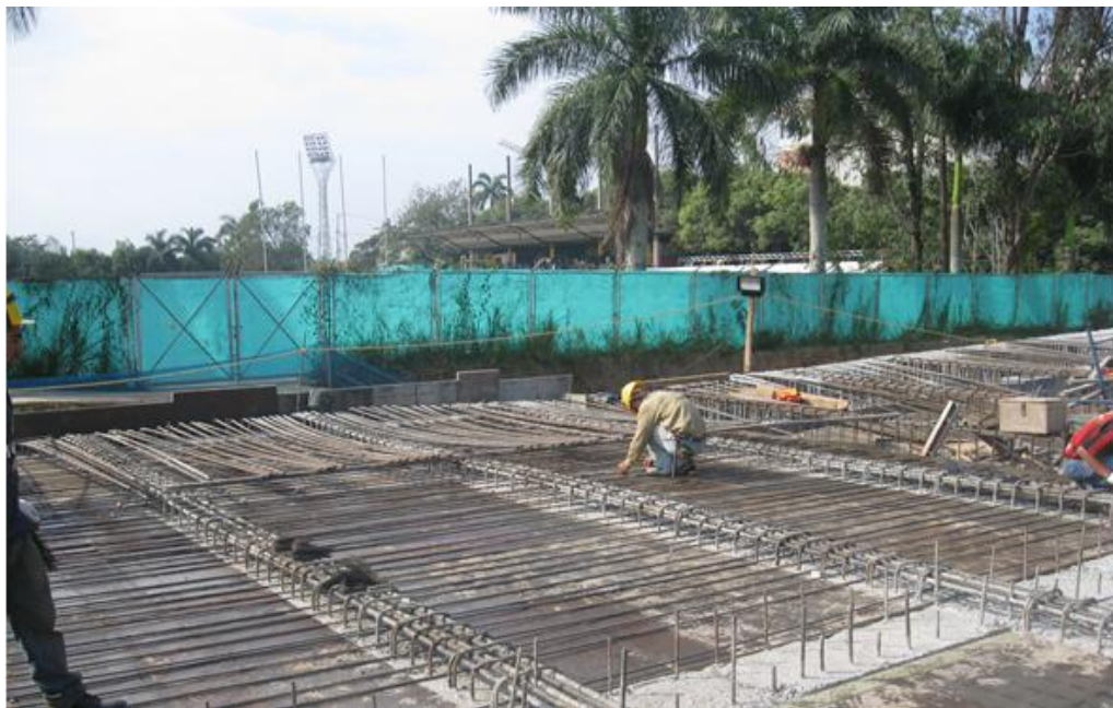
Figura 74. Refuerzo viga maciza sobre muros MPN eje 4
