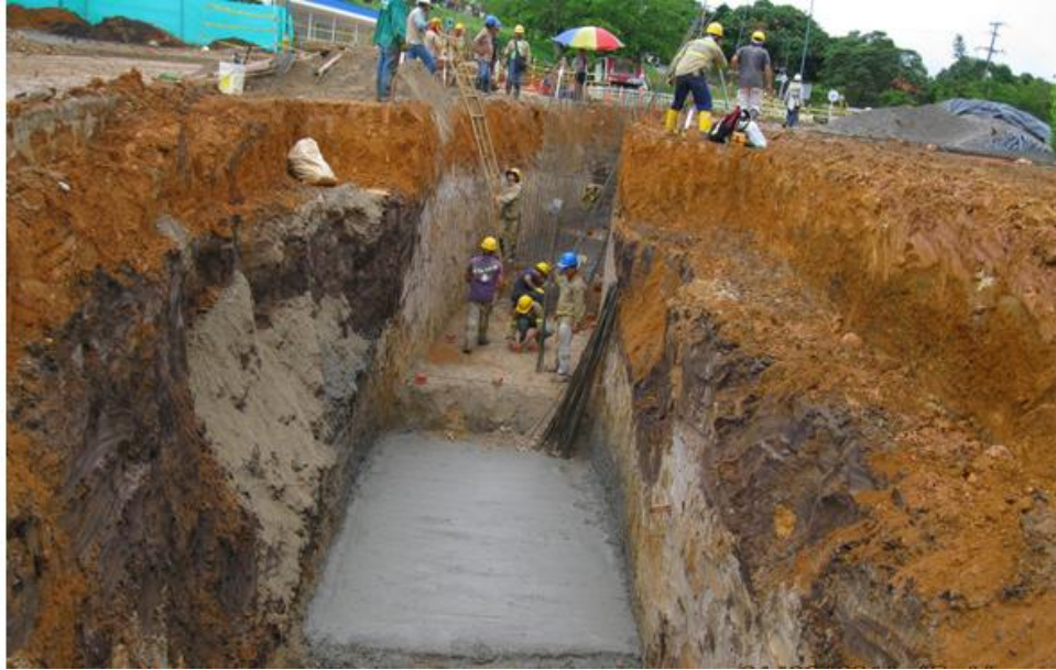
Figura 14. Concreto pobre o de limpieza
