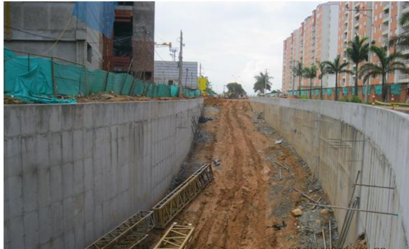
Figura 66. Vista en obra de los muros MPW y MWVh
