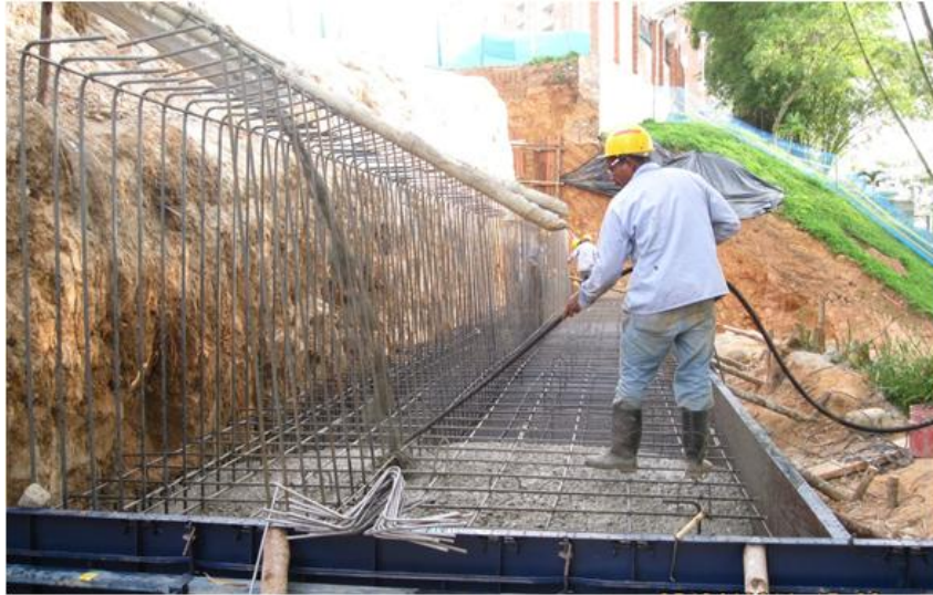
Figura 28. Vibrado del concreto empleado en zapatas
