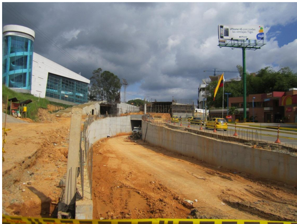
Figura 69. Vista en obra de los muros MVhN
