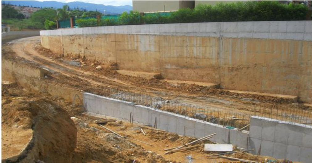
Figura 53. Muros MVh en obra.
