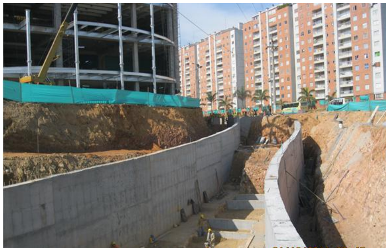
Figura 41. Muros de contención eje 6 - deprimido
