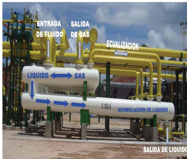
Figura 30. Funcionamiento de Slug Catcher Tipo Tubería
