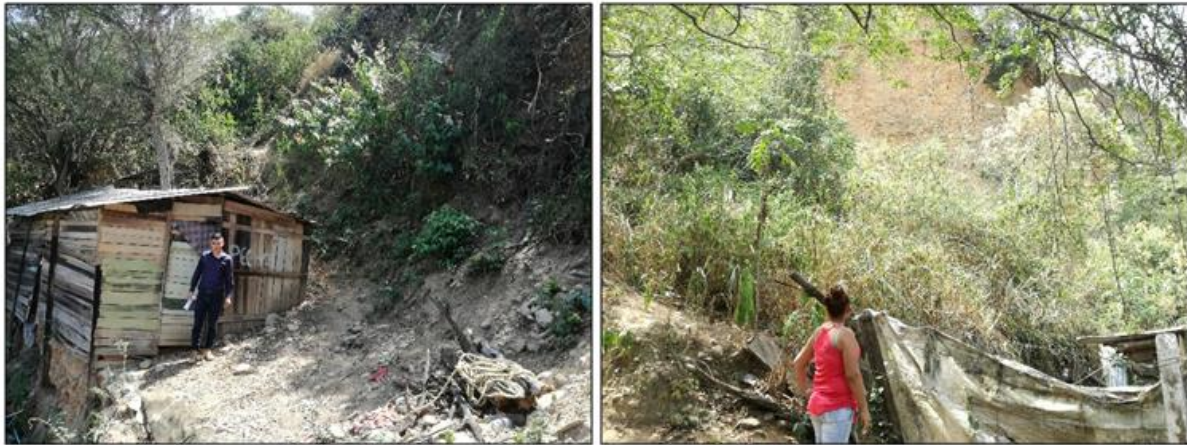
Figura 32. En las imágenes se observa el flujo de detritos sobre el asentamiento Rincón de La Paz. Estaciones 6 y 3, consecutivamente.
