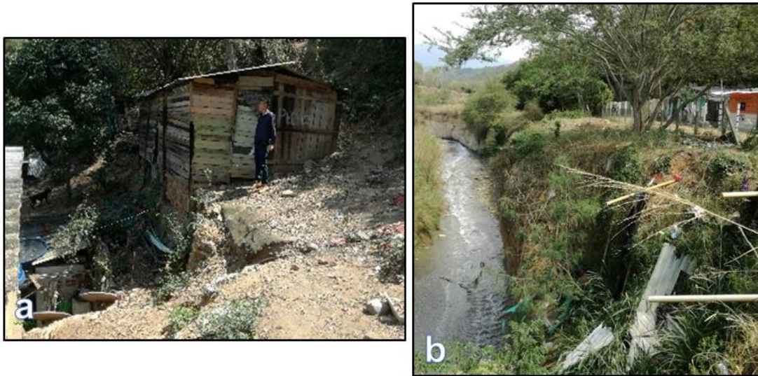
Figura 25. En la foto a (Estación 6), se observan las laderas explanadas para construcción de viviendas y en la foto b (Estación 9), se observan las terrazas de la quebrada Chimitá sobrepuestas con rellenos de escombros y desechos que, han sido explanados con el mismo objetivo de edificación en el asentamiento Rincón de La Paz.
