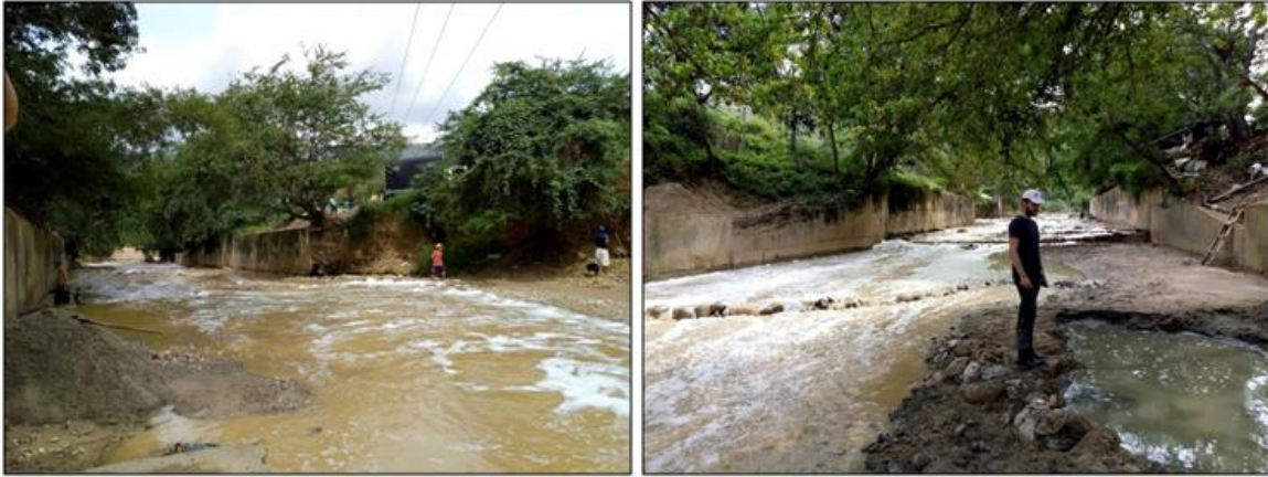
Figura 49. Foto 11 (izquierda) y foto 12 (derecha) en estas imágenes se observa como la extracción de las gravas y arena de la quebrada por parte de los pobladores del asentamiento contribuye al socavamiento y la posterior erosión de las obras de mitigación.
