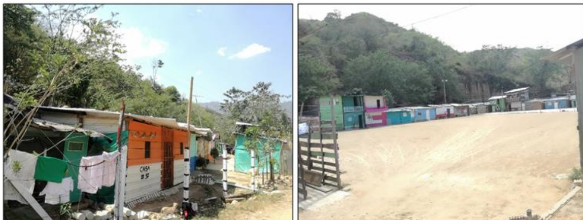
Figura 35. Zonas urbanizadas en la que se observan viviendas y una cancha de fútbol en tierra. Estaciones 1 y 10, consecutivamente.
