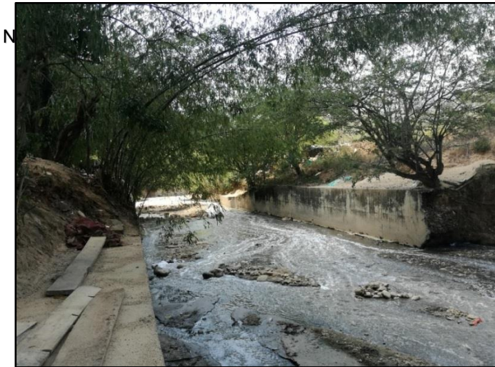
Figura 42. Obra de Canalización del sistema de drenaje (CD) de la quebrada Chimitá. Estación 8.
