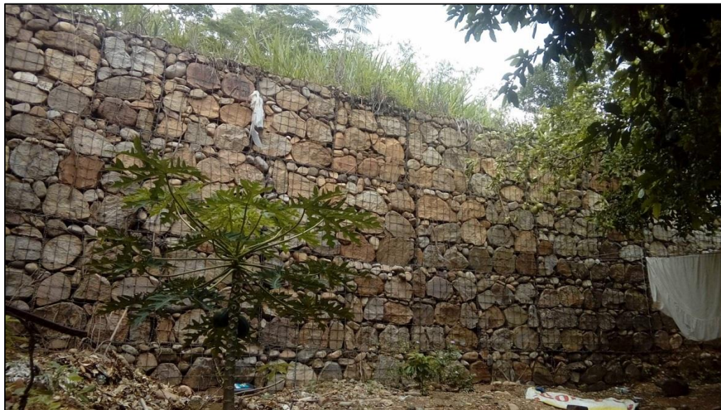
Figura 41. Muro en Gaviones (MG) presente en el talud de la ladera posterior al asentamiento. Estación 21.
