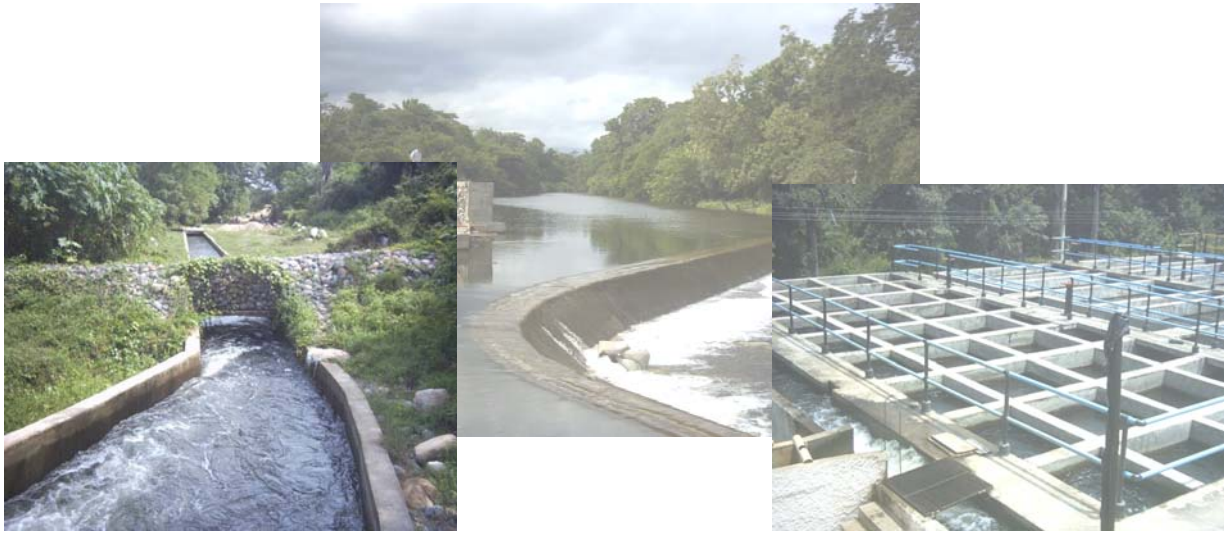
Foto N° 5, 6 y 7 Bocatoma, canal de conducción y planta de tratamiento del acueducto de Riohacha abastecido por el río Tapias
