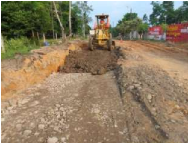
Figura 21 Mejoramiento de banca con material cobertura
