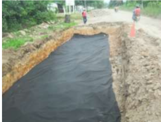
Figura 23 Colocación de geotextil para construcción del cuerpo del terraplén.
