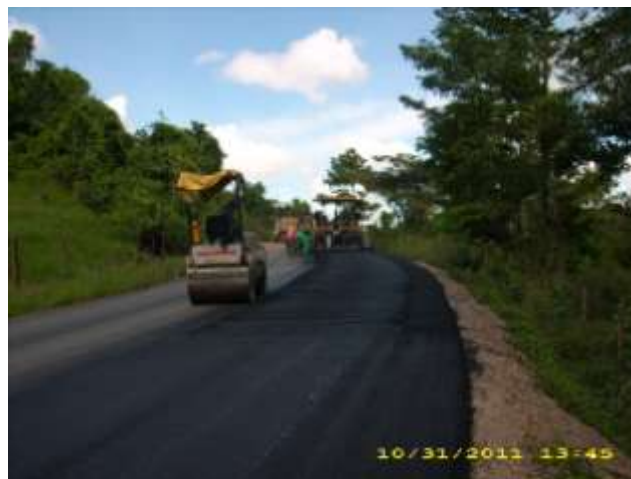
Figura 46 Compactación inicial con vibrocompactador
