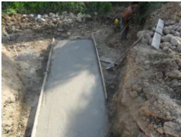
Figura 12 Solado de limpieza
