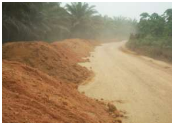
Figura 24 Descargue del material en la vía
