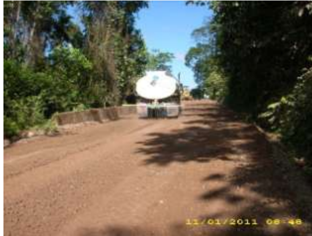
Figura 36 Humedecimiento de la base granular
