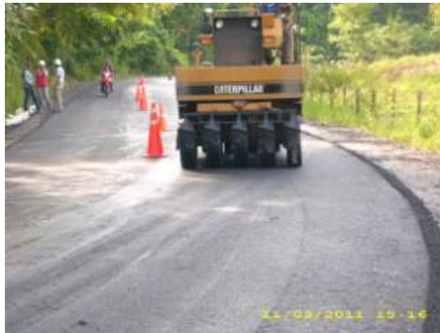
Figura 48 Compactación con compactador de llantas
