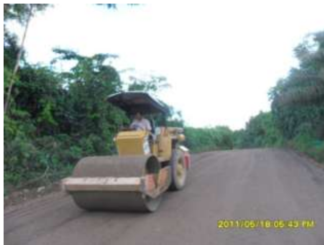
Figura 37 Compactación de base granular
