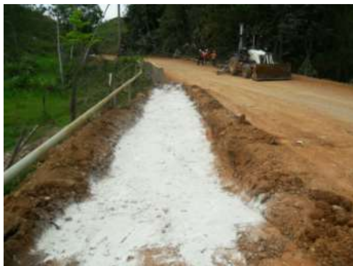
Figura 27 Terraplén estabilizado con cal
