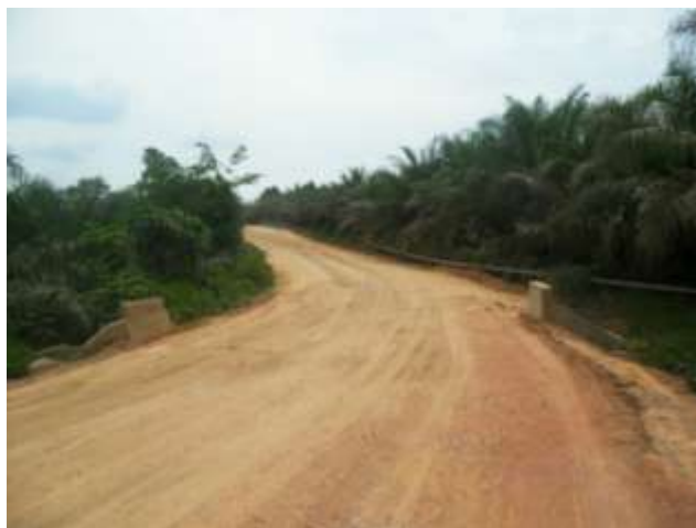
Figura 32 Superficie compactada para construcción de base granular
