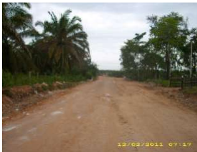
Figura 29 Corona del terraplén
