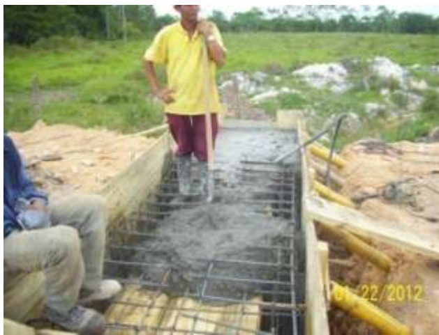
Figura 10 Fundida de boxculvert
