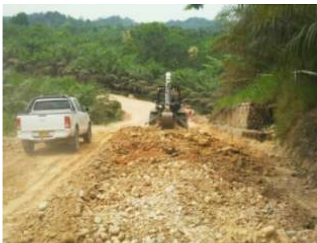
Figura 22 Escarificación del terreno base
