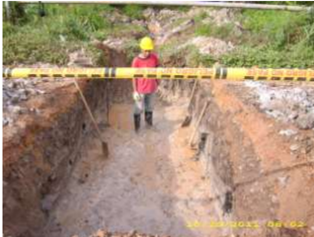
Figura 6 Excavación para boxculvert
