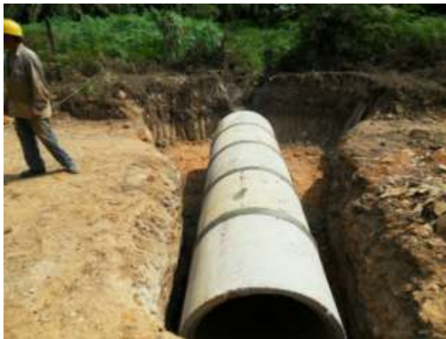
Figura 14 Tubería brechada
