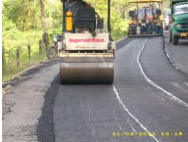
Figura 47 Compactación con vibrocompactador de rodillo
