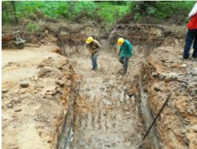
Figura 11 Excavación para alcantarilla
