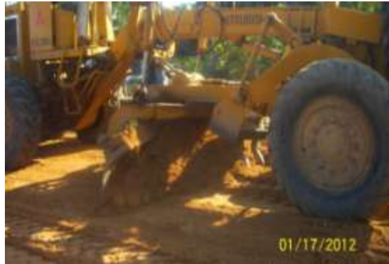
Figura 26 Detalle de la extensión del material con motoniveladora
