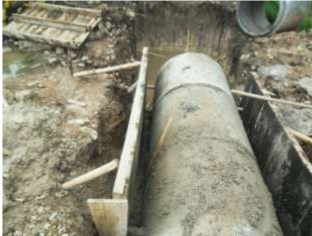
Figura 15 Atraque para tubería
