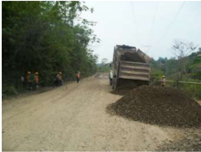
Figura 33 Colocación de base granular
