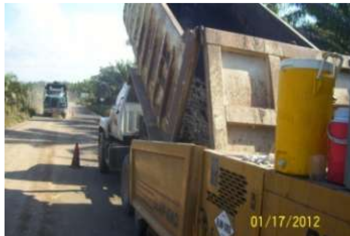
Figura 41 Descargue de la mezcla en obra
