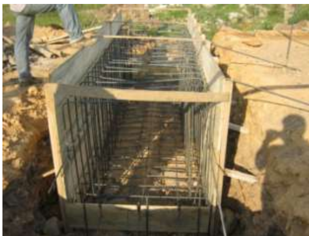
Figura 9 Acero de refuerzo y formaleta
