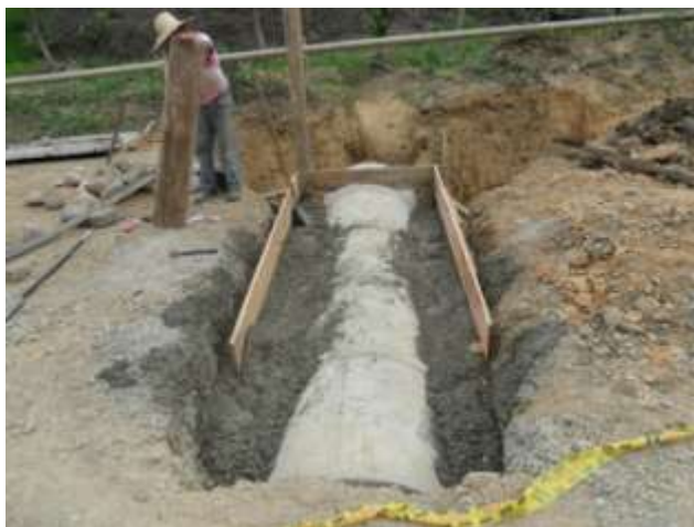
Figura 16 Colocación de concreto hidráulico
