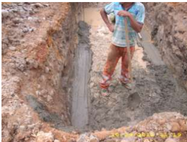
Figura 7 Solado de limpieza
