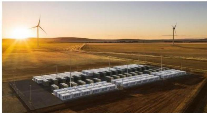
Nota: La Figura 3 muestra la planta de almacenamiento construida en Hornsdale (100MW/129MWh). Tomado (NEOEN, 2019)
