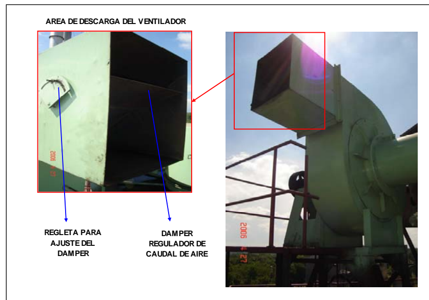
Figura 8. Detalle d mper de descarga de ventilador en sistema de separaci n neum tica de fibras.
