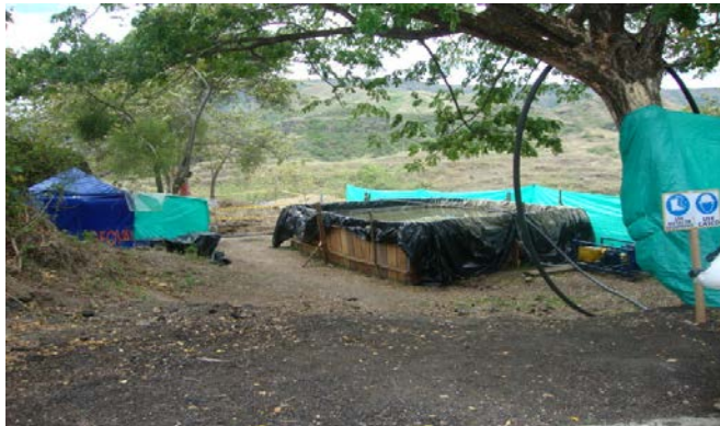
Ilustración 13. Piscina de Lodo de Perforación
