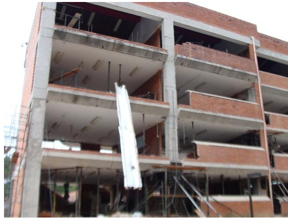
Figura 3. Vista posterior FCUIS durante reforzamiento estructura
