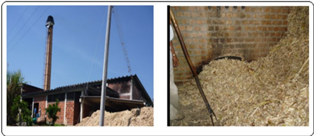
Figura 46 Estructura del trapiche tipo cimpa
