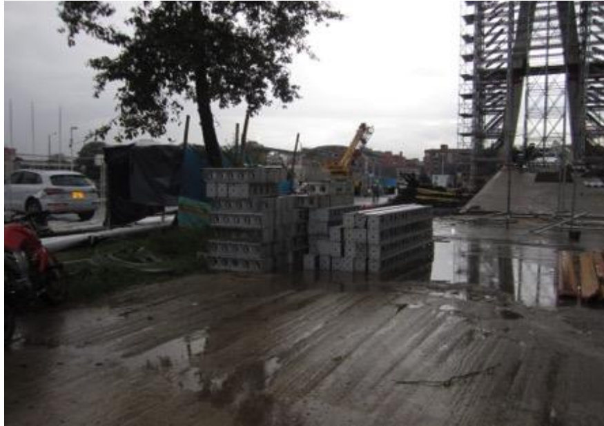
Fotografía - 4 Disposición de herramientas y equipos en patio de almacenamiento
