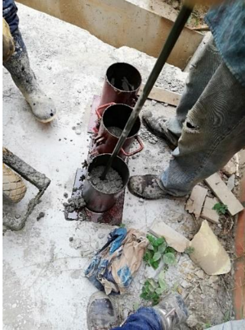
Figura 19. Fundición de cilindros de concreto de pozo número 4.
