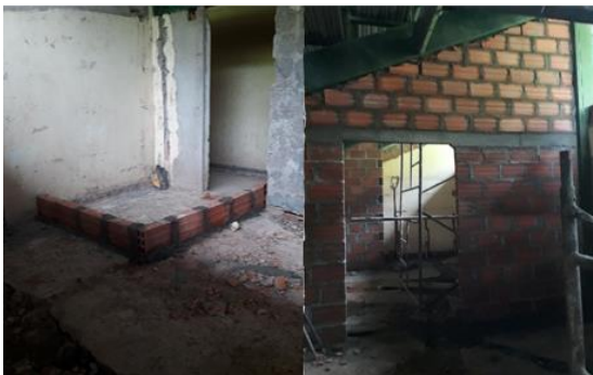
Figura 11. Replanteo e instalación de mampostería en bloque h10
