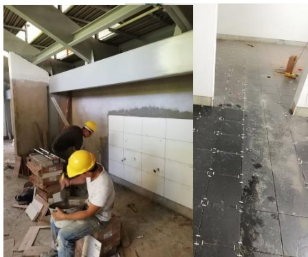
Figura 22. Enchape de piso y muros.
