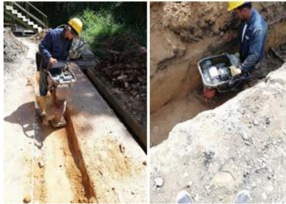
Figura 20. Compactación de material de relleno.
