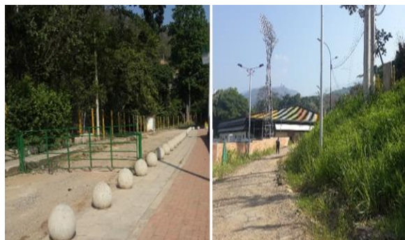
Figura 3. Estado de vía de acceso al coliseo antes de iniciar la obra.
