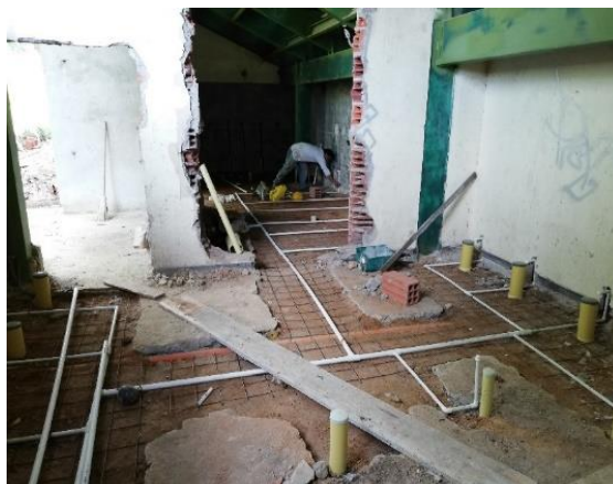
Figura 14. Redes hidráulicas en baterías de baños
