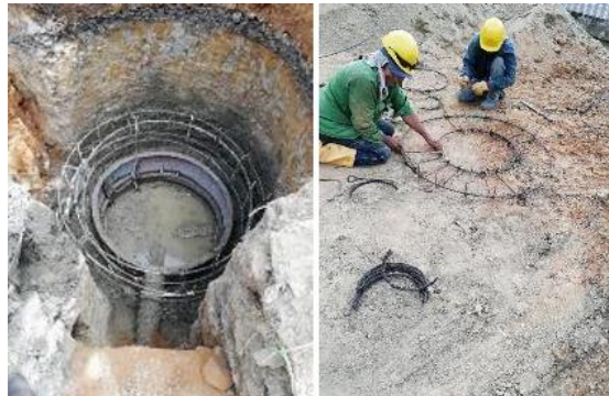
Figura 12. Seguimiento al armado e instalación de acero de pozos de inspección.
