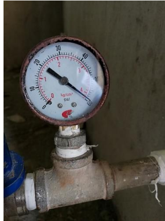
Figura 18. Prueba de presión red hidráulica en batería de baños número 6.
