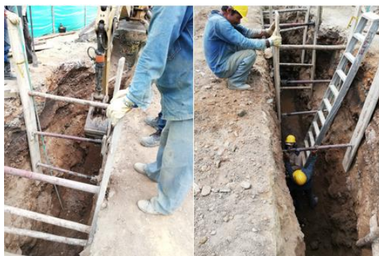
Figura 16. Excavaciones para alcantarillado a través de vía de acceso al coliseo
