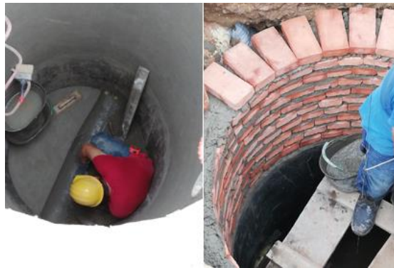
Figura 17. Construcción de pozos de inspección.
