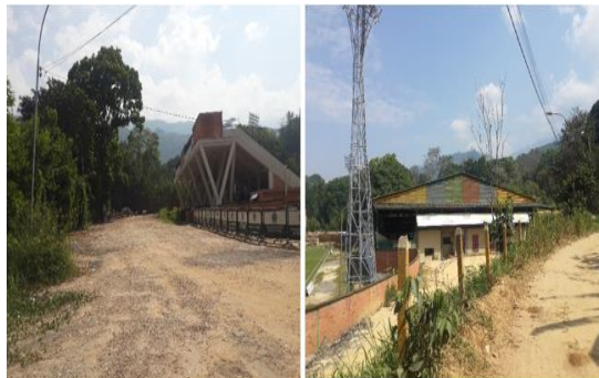
Figura 4. Estado de cerramiento de linderos del coliseo antes de iniciar la obra.
