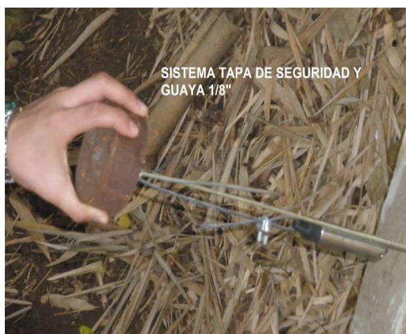
Figura 16. Sistema de Seguridad Equipos por medio de Guaya 1/8"
